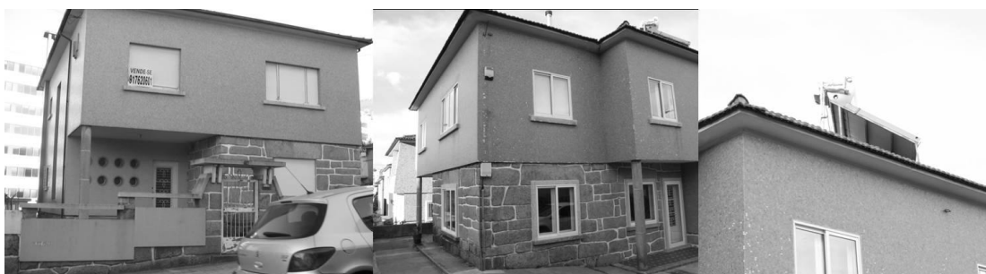
Figura 15: Imagens da habitação antes e depois das obras de reabilitação.
