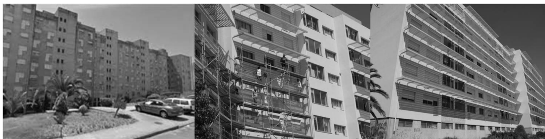
Figura 14: Imagens do conjunto de edifícios antes e depois da intervenção de reabilitação.
