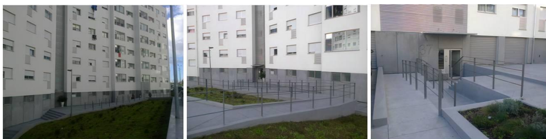
Figura 27: Imagem das rampas de acesso aos edifícios realizadas na obra de reabilitação.
