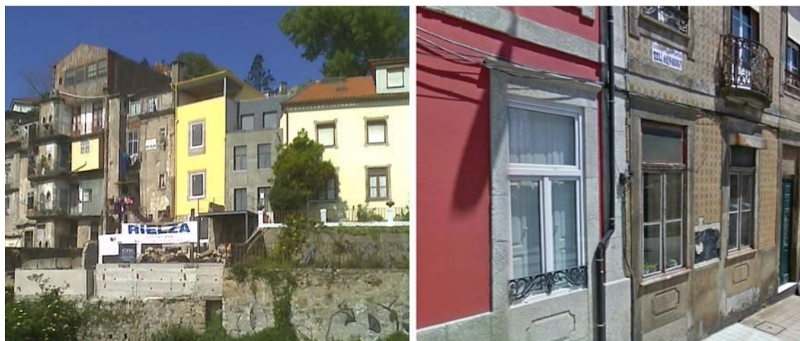
Figura 9: Edifícios similares com a mesma idade e diferentes estados de conservação. Um exemplo de que as ações de manutenção e reabilitação são, determinantes para a longevidade da construção.
