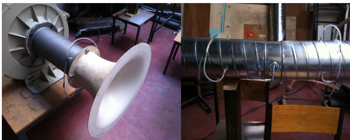
Figura 3-13: Tomadas de Pressão na tubeira / instalação do Registo Regulador de Caudal
