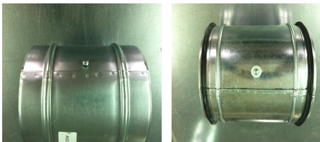
Figura 4-14: Alteração da colocação dos acessórios do manípulo regulador
