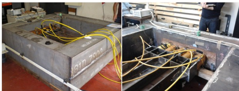
Figura 5.9. Aplicação de carga distribuída no grande reforço
