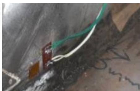
Figura 5.10. Extensómetros 1 e 2 presentes no grande reforço Weldox 700
