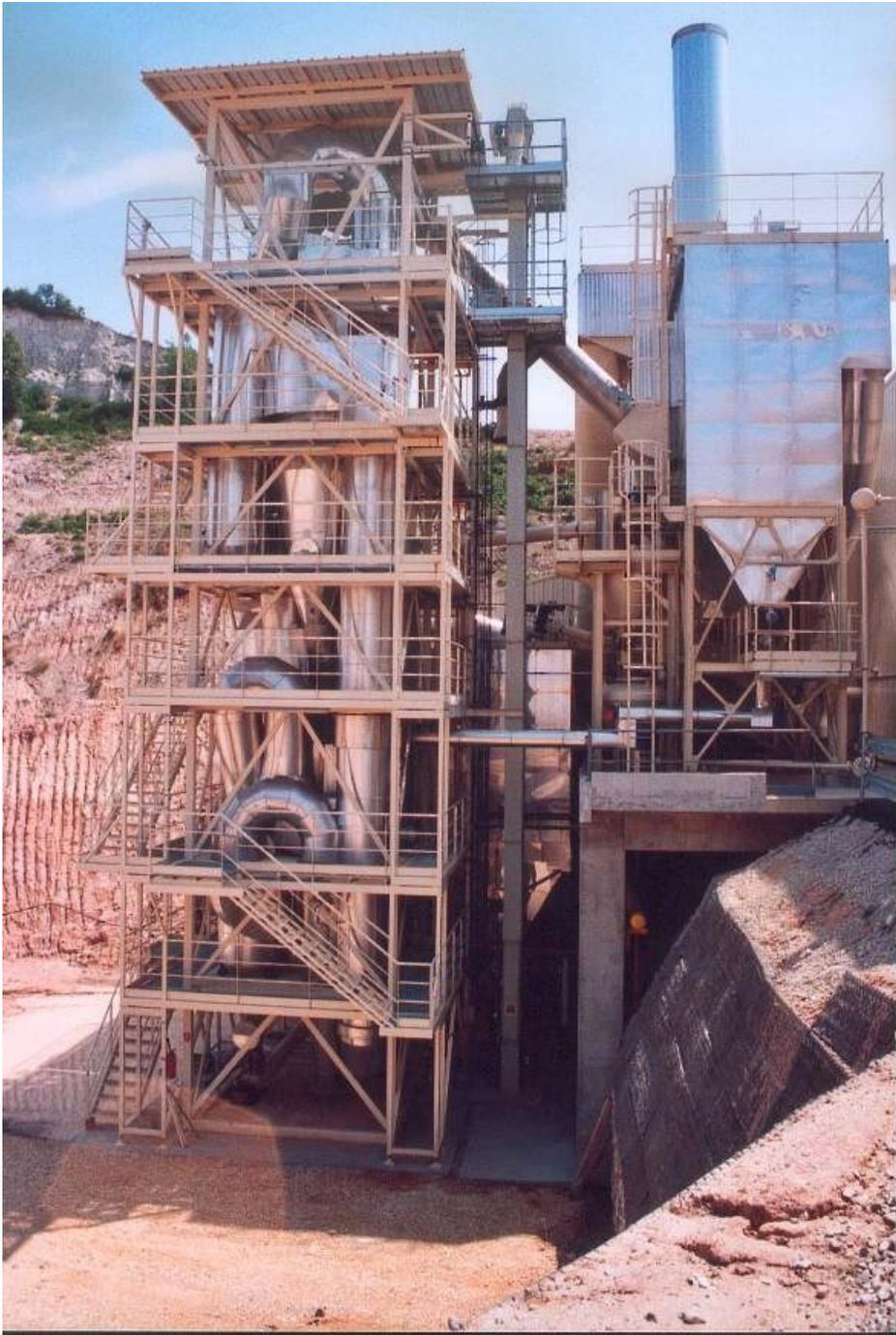
*Figura 2.2: Instalação industrial de produção de pozolanas por calcinação instantânea*
