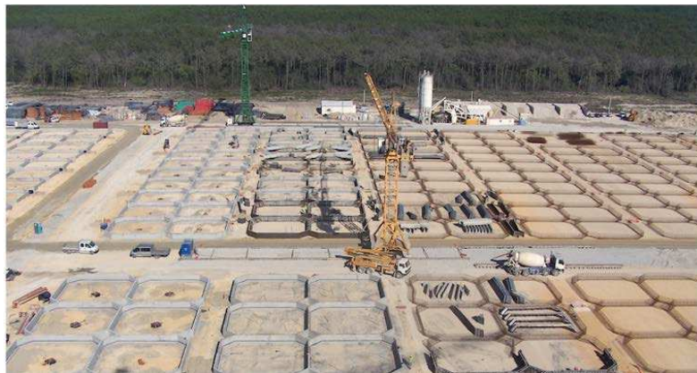
Figura 22 - Instalação aquícola (Unibetão, 2011)
