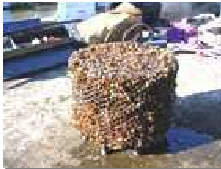
Figura 46 - Obstrução provocada pelos moluscos nas grades de proteção
