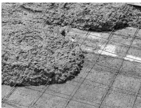
Fig. 11 - Aplicação de betonilha reforçada com malha electrossoldada
