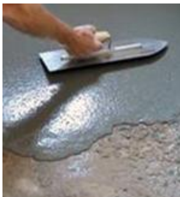
Fig. 10 - Aplicação de endurecedor de superfície
