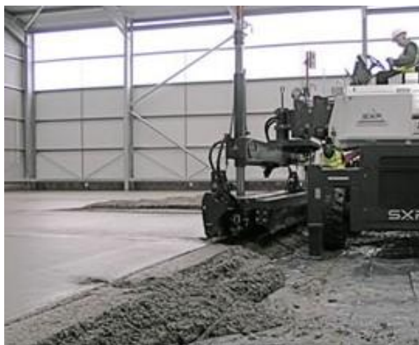
Fig. 1 - Pormenor de aplicação de betoniha de enchimento e finalização da superfície, em simultâneo, efectuado pela empresa "A.J. Clark Group - Scotland" (2).
