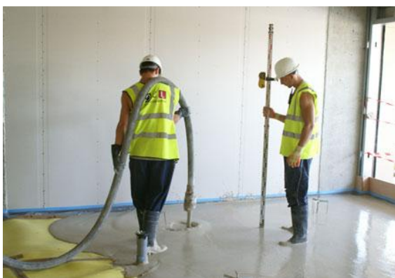
Fig. 2 - Aplicação de betonilha autonivelante pela empresa “OCL Facades – Essex” (11).
