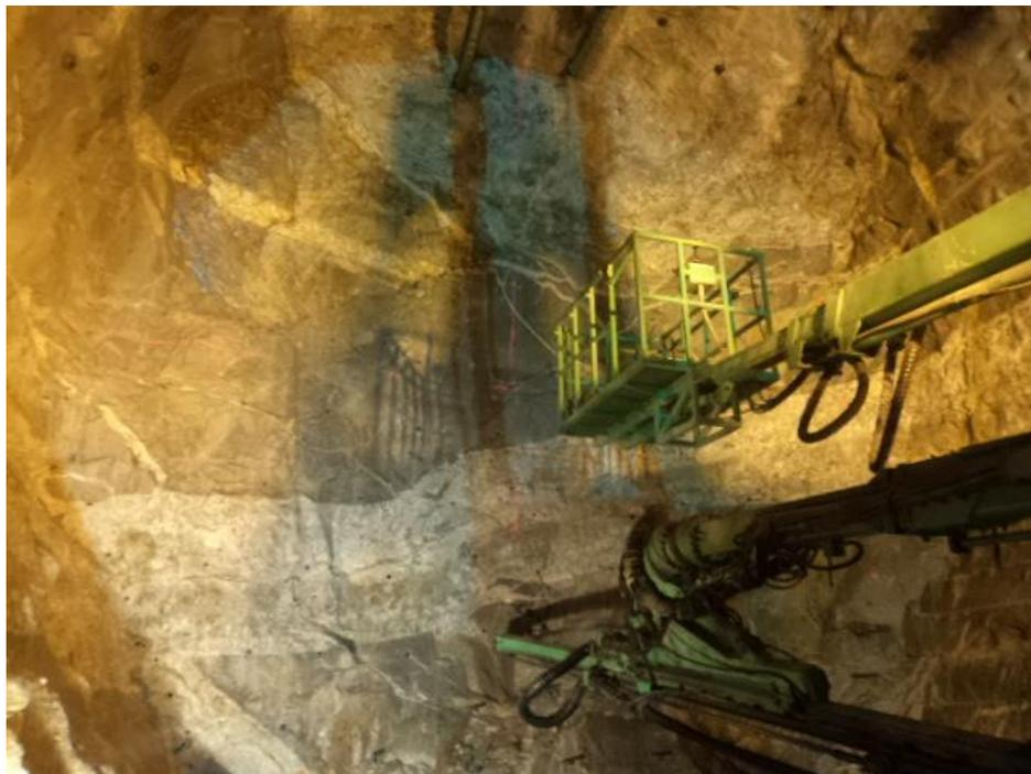
Figura 22 – Observações de corpos aplito-pegmatíticos no Túnel em Carga.
