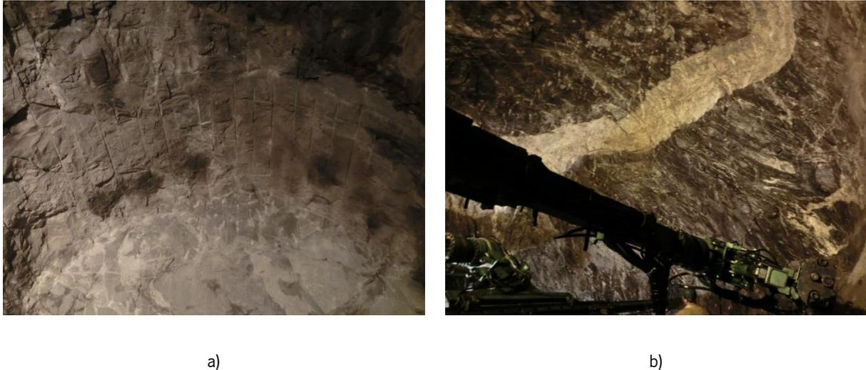
Figura 21 – Aspeto litológicos nas frentes do Túnel em Carga a) granito de grão médio a grosseiro, de 2 micas; b) micaxisto e filões aplito-pegmatíticos.
