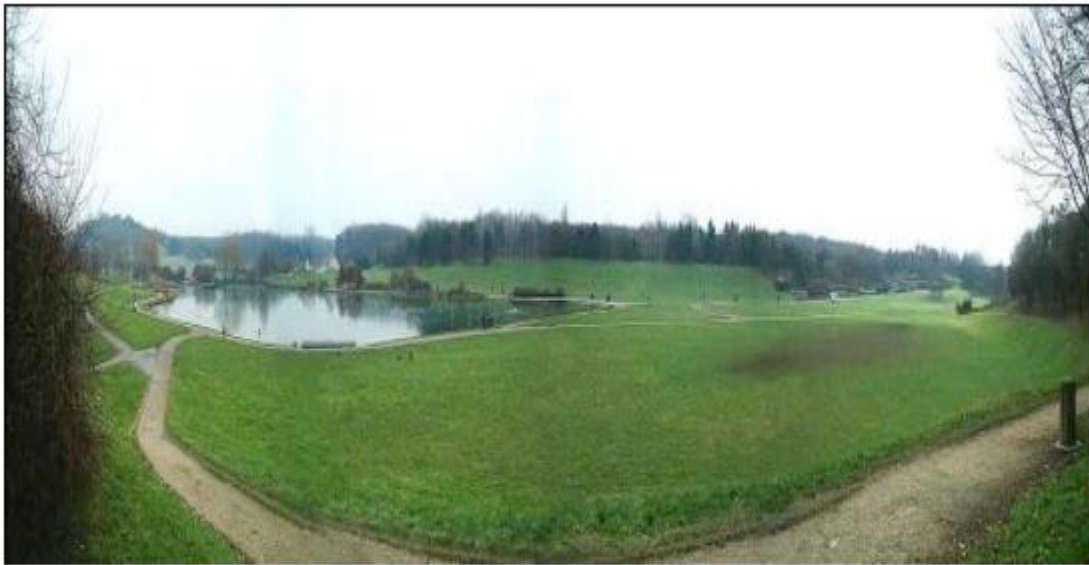
Figura 2.14 : Bacia de retenção com nível de água permanente, Parc de la Courneuve, França (Renaudie 2005)
