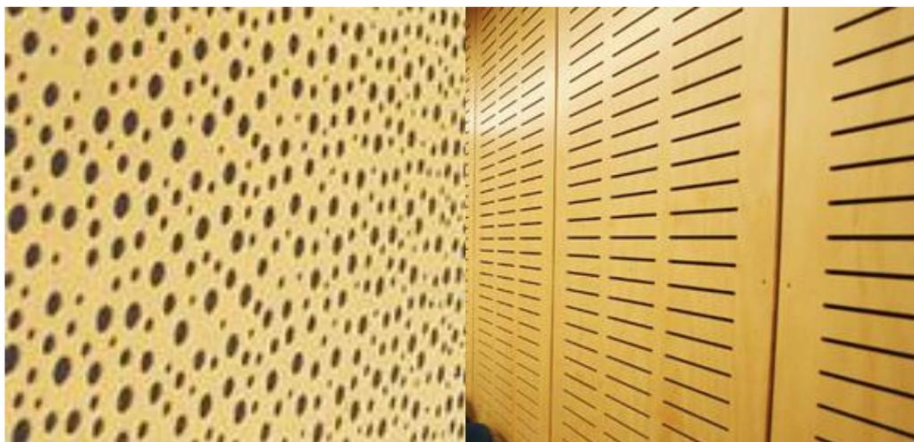
Figura 63 - placas de contraplacado de madeira perfurada e painéis ranhurados.
