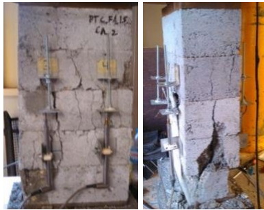
Fig. 8 – Modo de rotura de um dos prismas ensaiados à compressão (SFA15).
