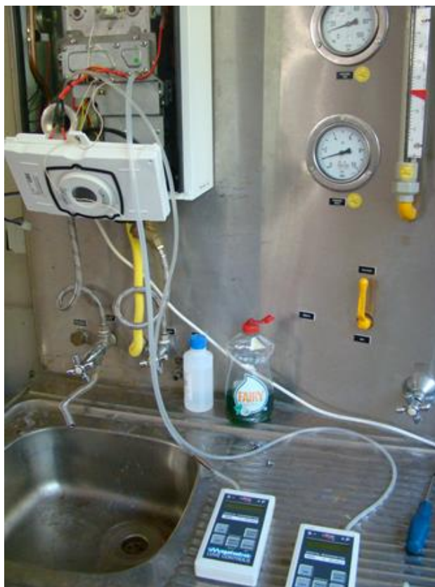
Figura 5.6 - Utilização dos manómetros para recolha de pressões estáticas no queimador e na tubeira
