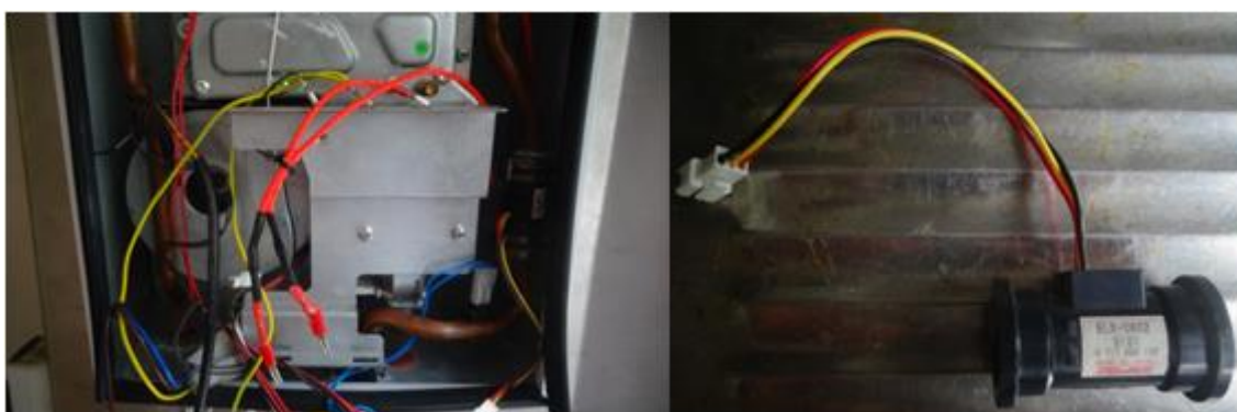
Figura 4.14 - À Esq. posição do caudalímetro à Dir. o caudalímetro ELK-0602
