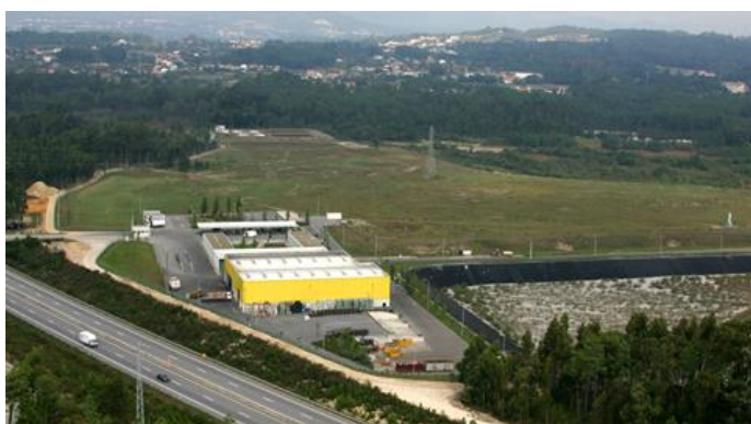
Figura 1. Vista aérea do Aterro Sanitário do Vale do Lima e Baixo Cávado (Resulima, 2013).
