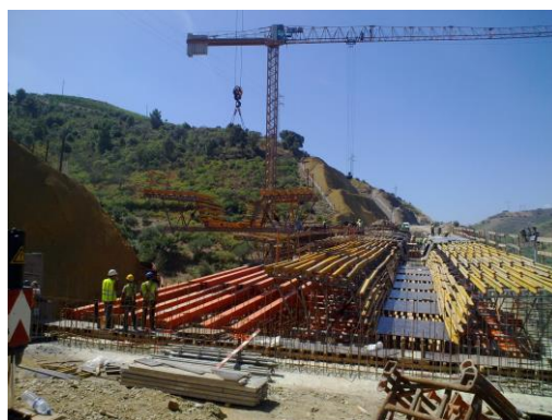
Figura 29. Viaduto 1 - Lote 3 - Subconcessão do Douro Interior, Vila Nova de Foz Côa
