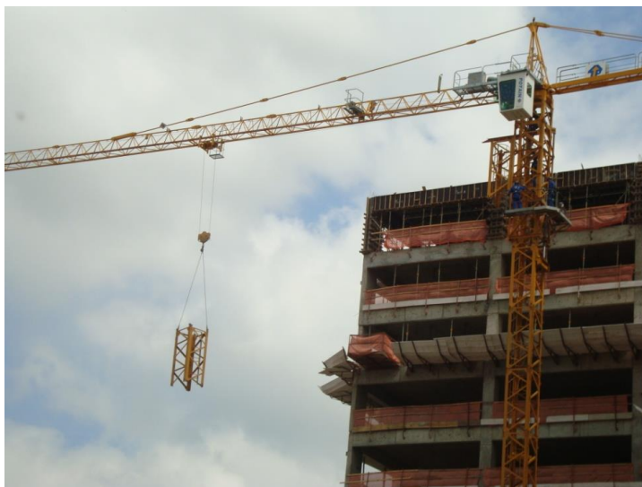
Figura 11. Processo de inserção de um elemento da torre durante a telescopagem de uma grua torre fixa (fonte: Moura e Carreiro)
