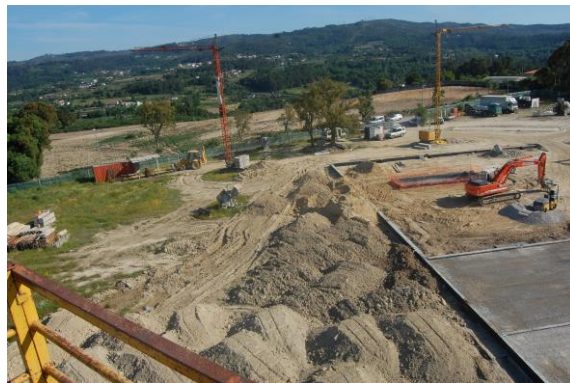
Figura 27. Complexo Industrial BRACICLA Unipessoal Lda., Amares
