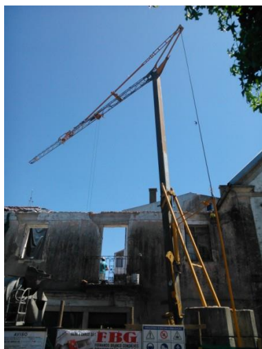
Figura 28. Edifício com Preservação de Fachada, Monção
