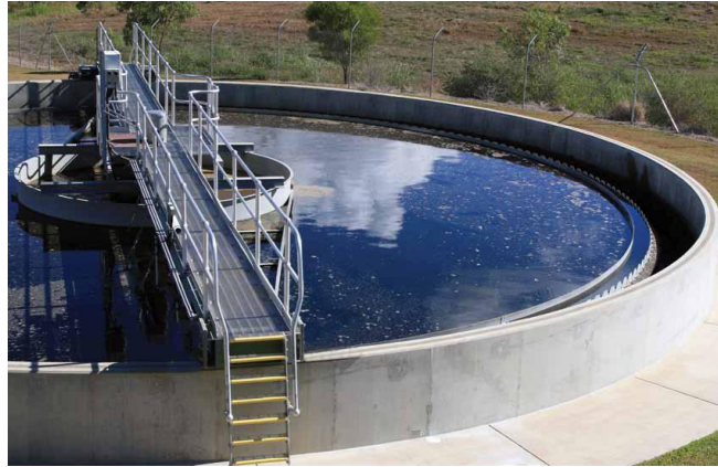
Figura 4 - Sedimentador Circular (disponível em, http://encyclopedia.che.engin.umich.edu )
