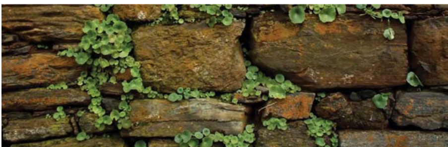
Fig.6 Inércia térmica proporcionada pelas espessas paredes de xisto
