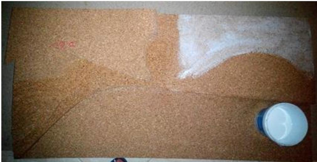
Figura 46 – Colagem das placas de grandes dimensões
