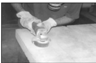
a) Preparação da superfície (manta)
