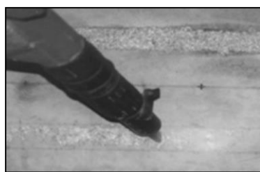
b) Preparação da superfície (laminado)
