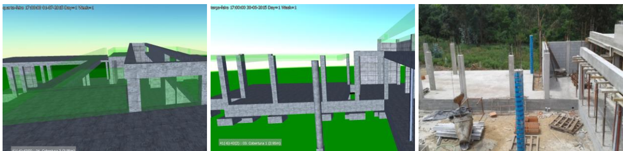
Figura 4.42 – Evolução das atividades construtivas no dia 01.07.2015: a) Planeado; b) Real; c) fotografia da obra
