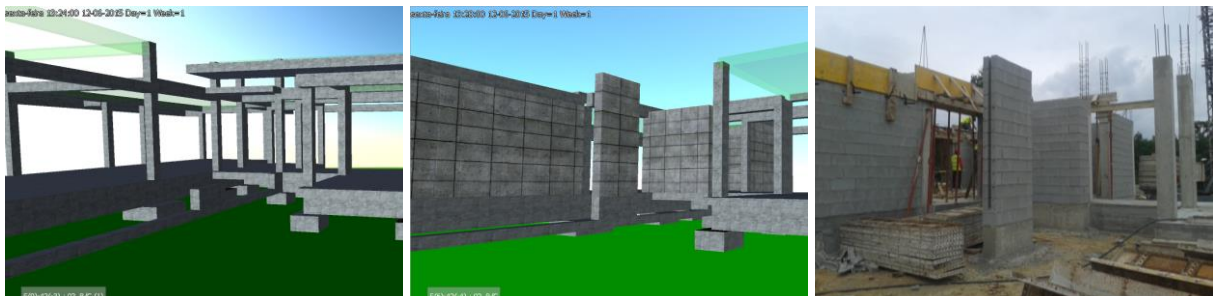
Figura 4.41 – Evolução das atividades construtivas no dia 12.06.2015: a) Planeado; b) Real; c) fotografia da obra
