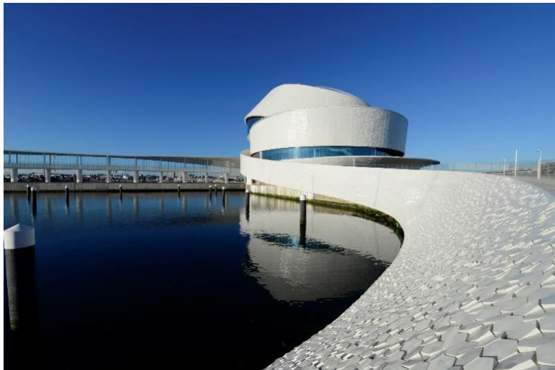
Figura 2.25 – Terminal de Cruzeiros do Porto de Leixões após construção
