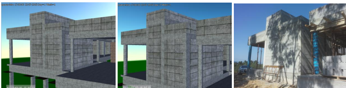
Figura 4.44 - Evolução das atividades construtivas no dia 22.07.2015: a) Planeado; b) Real; c) fotografia da obra
