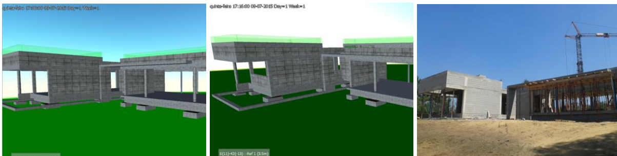
Figura 4.43 - Evolução das atividades construtivas no dia 10.07.2015: a) Planeado; b) Real; c) fotografia da obra
