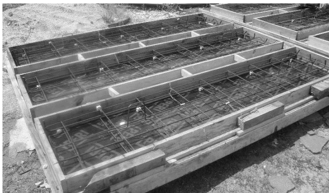
Figura 3.2 - Aspeto das armaduras após montagem e colocação na cofragem.
