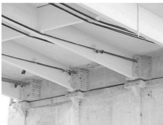
Figura 2.3 - Reforço do viaduto de acesso à Ponte Edgar Cardoso com pré-esforço exterior (Neves, 2012).
