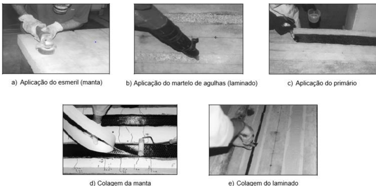
Figura 2.5 - Aplicação de sistemas de reforço de CFRP de acordo com a técnica EBR (Dias, 2001).
