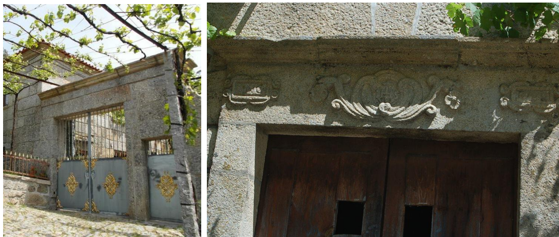
Figura 28 – Casa D. João de Aboim e Casa do Picão
