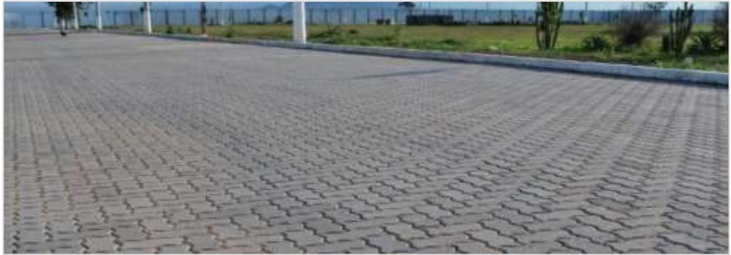
Figura 20 - Aplicação de pavimento de blocos de betão
