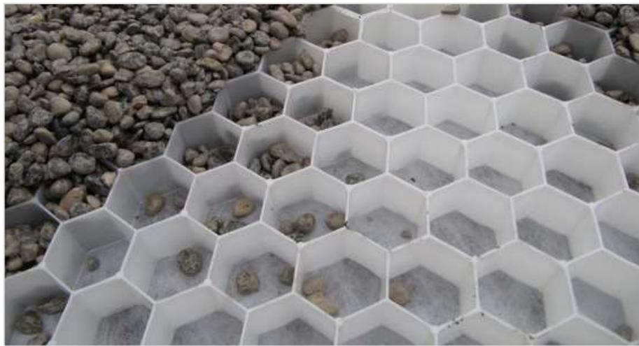
Figura 24 - Pavimento de geocélulas com preenchimento granular
