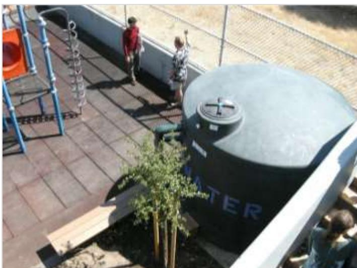
Figura 2 - Reservatório de armazenamento de água pluvial numa escola em São Francisco, Califórnia (E.U.A.), Fonte: www.millercomp.com
