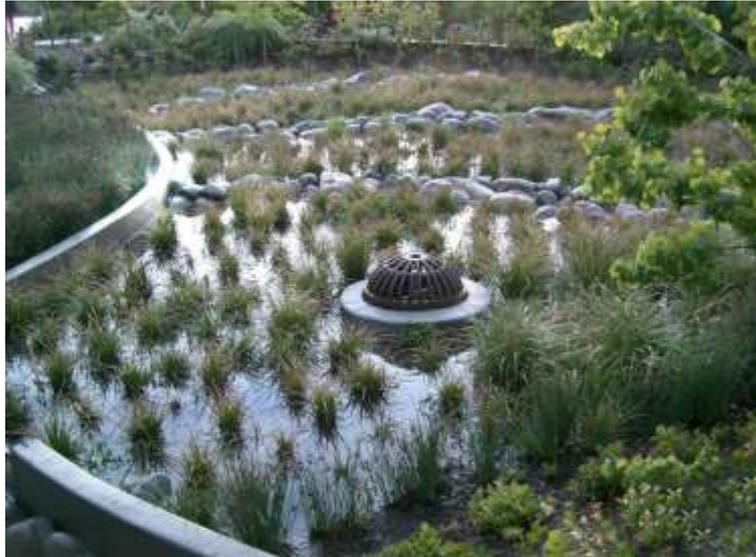
Figura 32 - Sistema de biorretenção com dreno de superfície, Fonte: Aquafluxus
