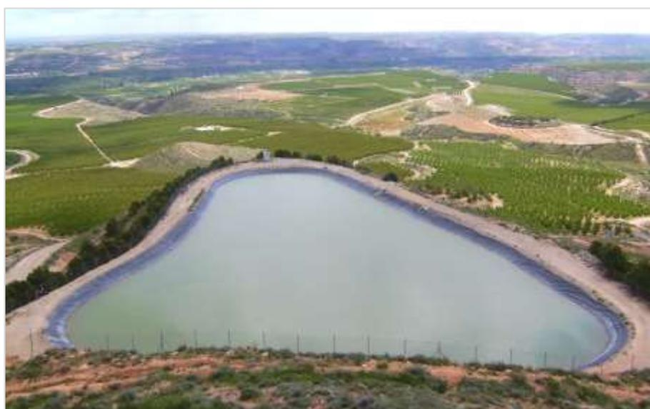
Figura 31 - Bacia de retenção com nível de água permanente, Fonte: [www.hidrotecsl.com](http://www.hidrotecsl.com)
