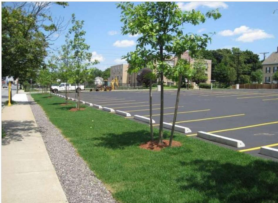
Figura 28 - Aplicação de trincheira de infiltração em parque de estacionamento
