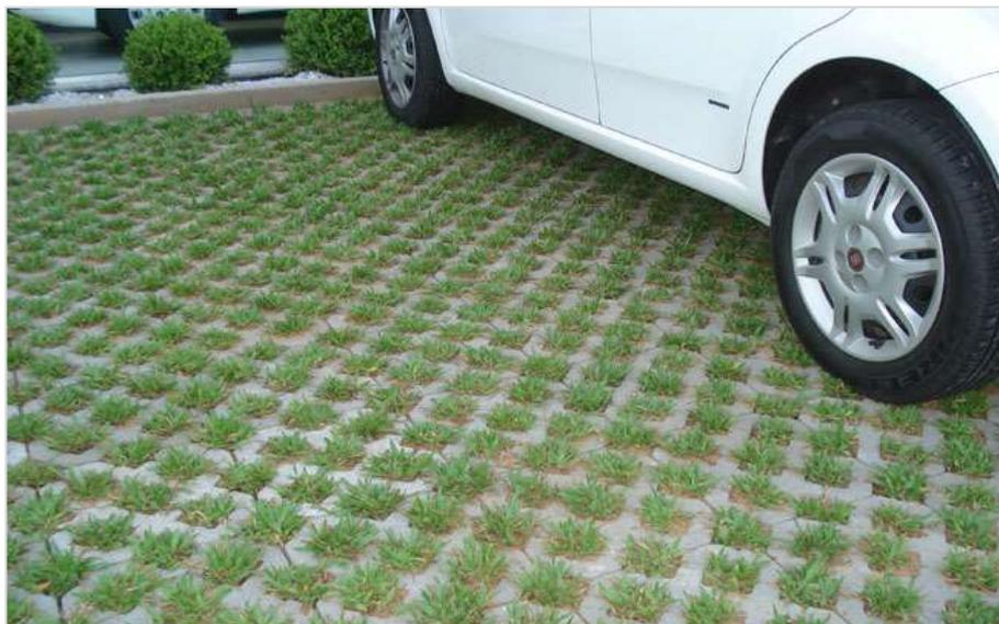
Figura 23 - Aplicação de blocos de betão vazados em zona de estacionamento
