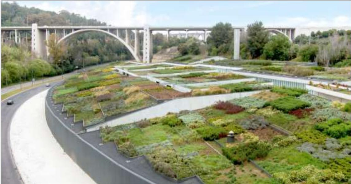
Figura 14 - Cobertura semi-extensiva localizada na ETAR de Alcântara
