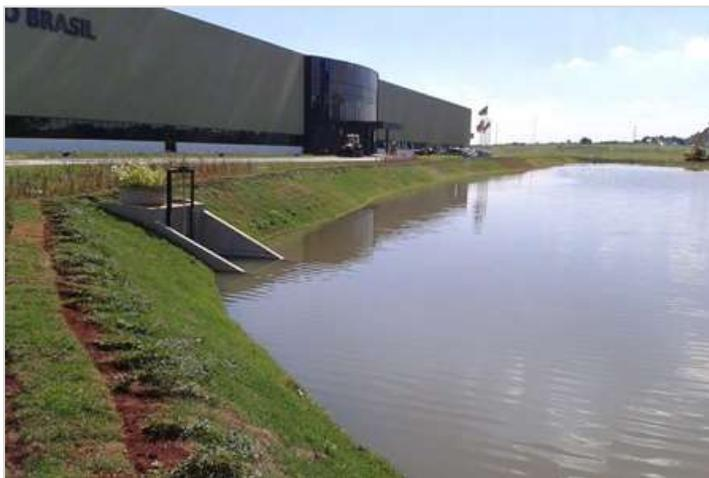
Figura 1 - Lagoa impermeabilizada para armazenamento de água pluvial para utilização industrial, Fonte: geosynthetica.net.br
