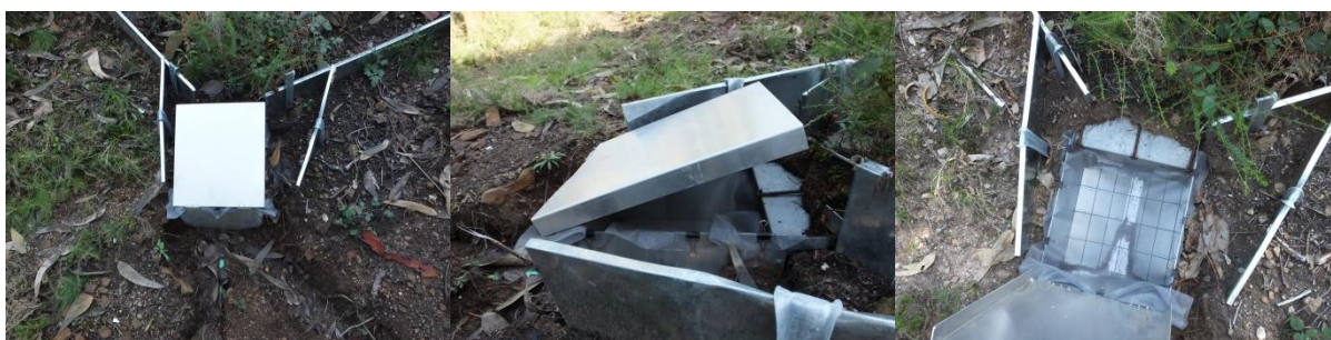
Fotografia 11 – Caixa de erosão
