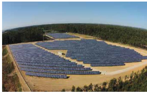
Figura 2.26 - EDP Renováveis (Estarreja 2MW) [22]
