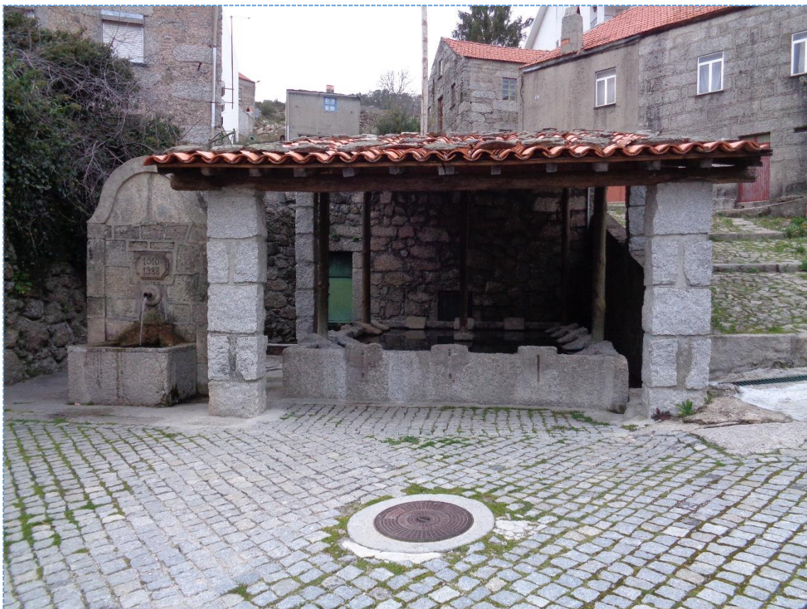
Figura 33: Fonte do Ferreiro e lavatório de roupa comunitário
