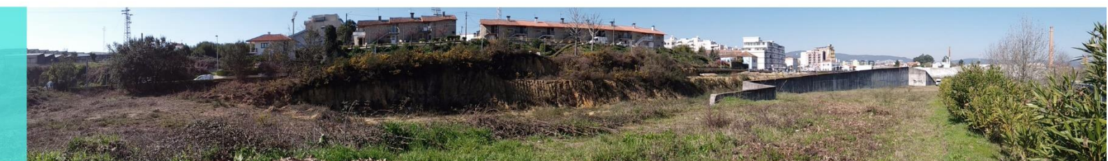
Figura 8_Panorâmica da linha férrea
