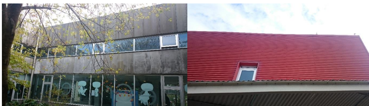
Figura 24. Fotos da platibanda interna e externa do Centro Educativo de Esposende (CEE)
