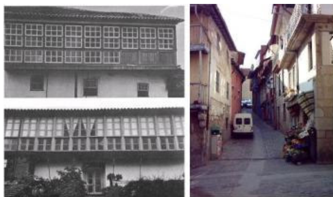
Figura 5 – A importância do factor solar na distribuição das varandas abertas ou envidraçadas.
