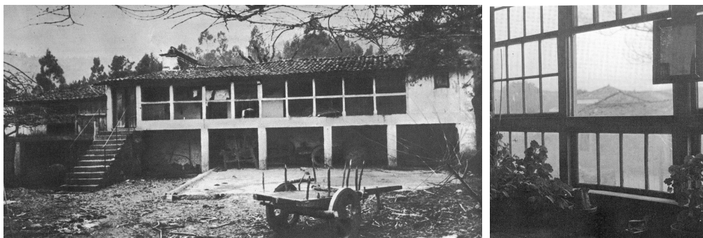
Figura 9 – Varandas envidraçadas com parede solar de fundo em pedra tradicional.
