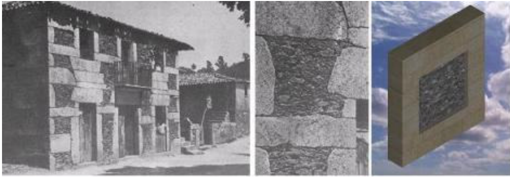
Figura 7 – Elementos de parede em pedra tradicional com características de captação e armazenamento passivo da energia solar.
