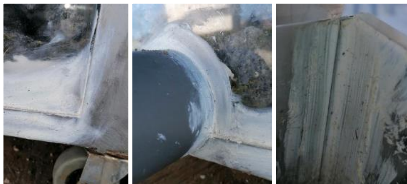
Ilustração 8 - Pormenores da selagem da estrutura dos CB
