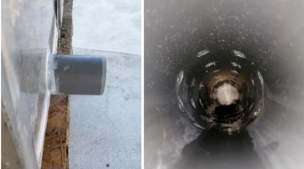
Ilustração 9 - Dreno perfurado colocado na saída dos CB
