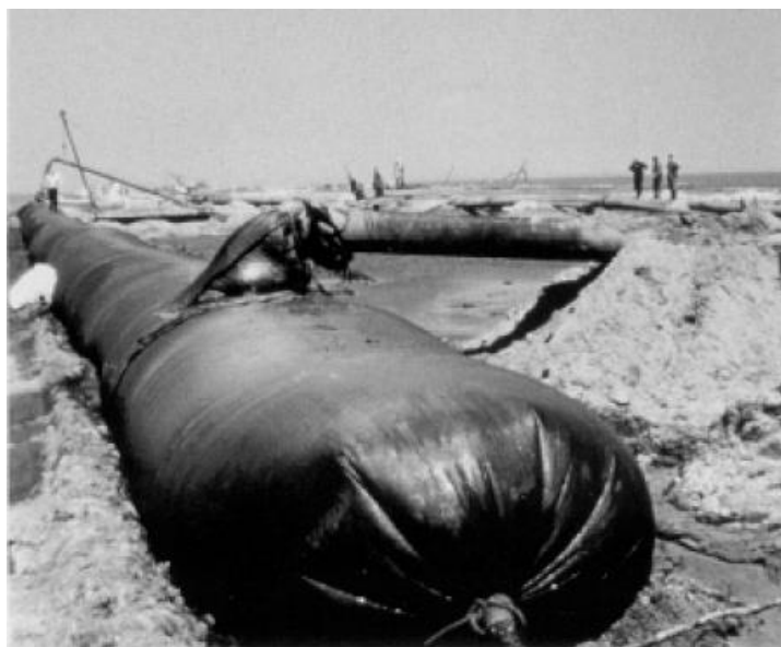
Figura 18 - Primeira aplicação de tubos de geotêxtil para proteção costeira, Holanda, 1962 (Castro et al., 2008)
