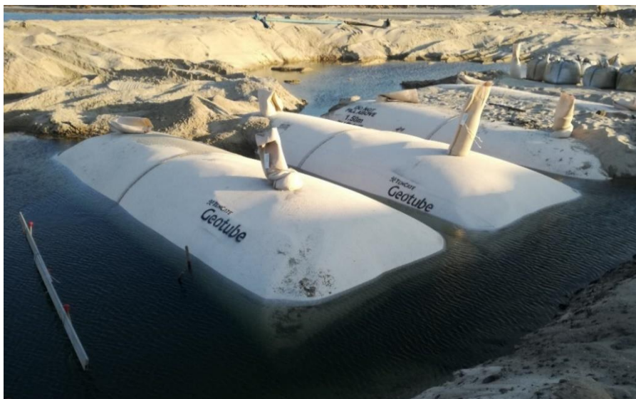
Figura 20 - Aplicação de cilindros geossintéticos, Praia de Esmoriz
