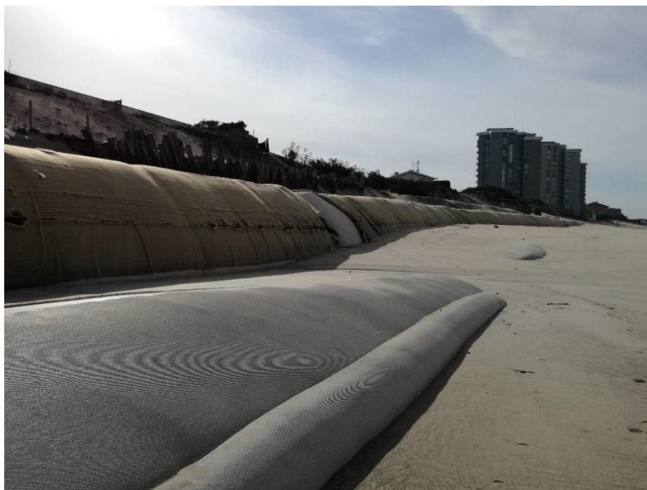
Figura 54 - Aspetos do sistema de reforço dunar na praia de Ofir em março de 2017
