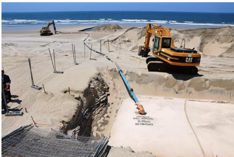
Figura 22 - Enchimento cilindros geossintéticos, Praia de Ofir 2015 ( http://concelhodeesposende.blogspot.pt/ )
