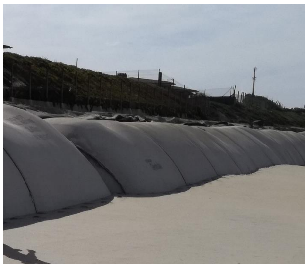
Figura 73 - Acreção sentida no trecho 5, junto dos cilindros geossintéticos
