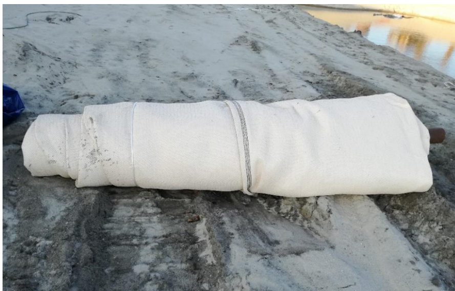
Figura 21 - Aspeto dos cilindros geossintéticos quando entregues em obra, Praia de Esmoriz
