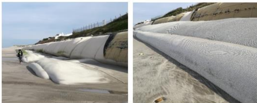
Figura 66 - Exposição dos cilindros geossintéticos nos trechos 4 e 5 (30.03.2017)
