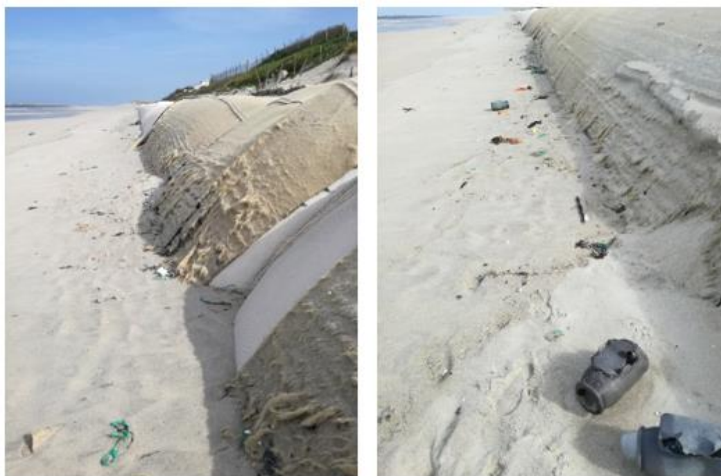
Figura 77 - Acumulação de resíduos verificada no ultimo dia de campanha, na base dos geossintéticos dos trechos 4 e 5 (15.05.2017)
