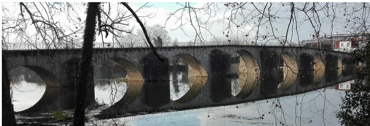
Figura 34 Vista montante parcial da ponte
