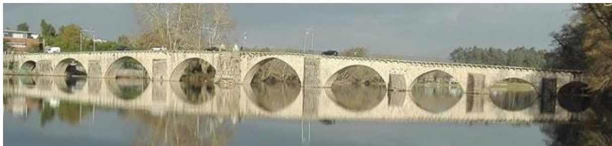
Figura 31 Vista jusante da ponte
