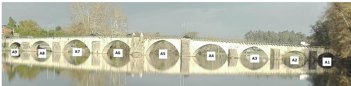
Figura 32 Vista jusante da Ponte do Prado - Identificação dos Arcos
