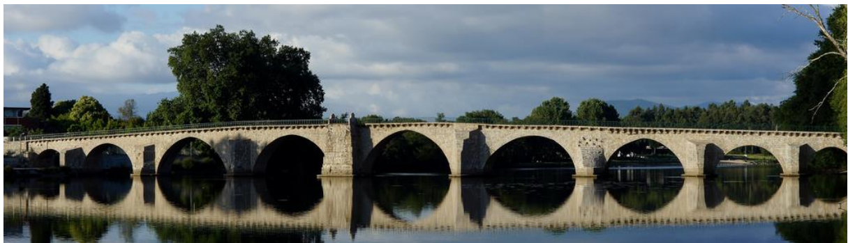
Figura 28 Vista geral da ponte do Prado
