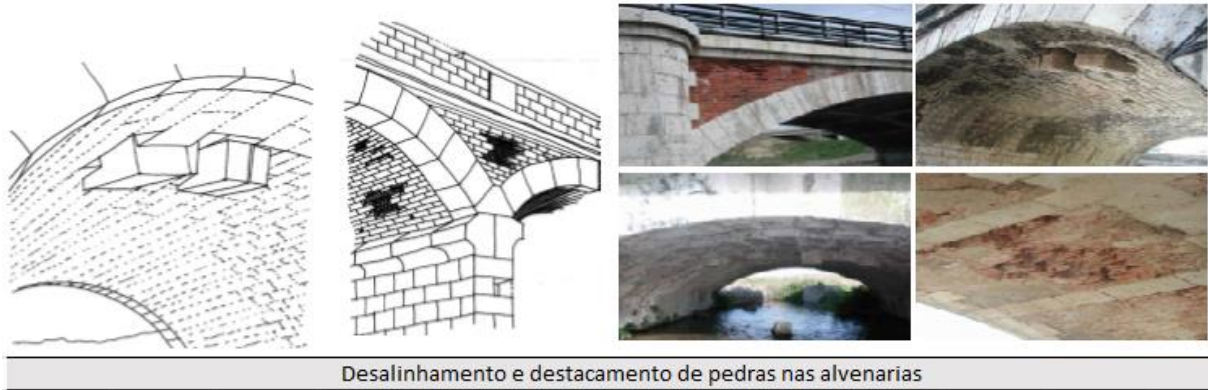
Figura 19 Desalinhamento e destacamento de pedras nas alvenarias (García-Catalán & Álamo, 2006)
