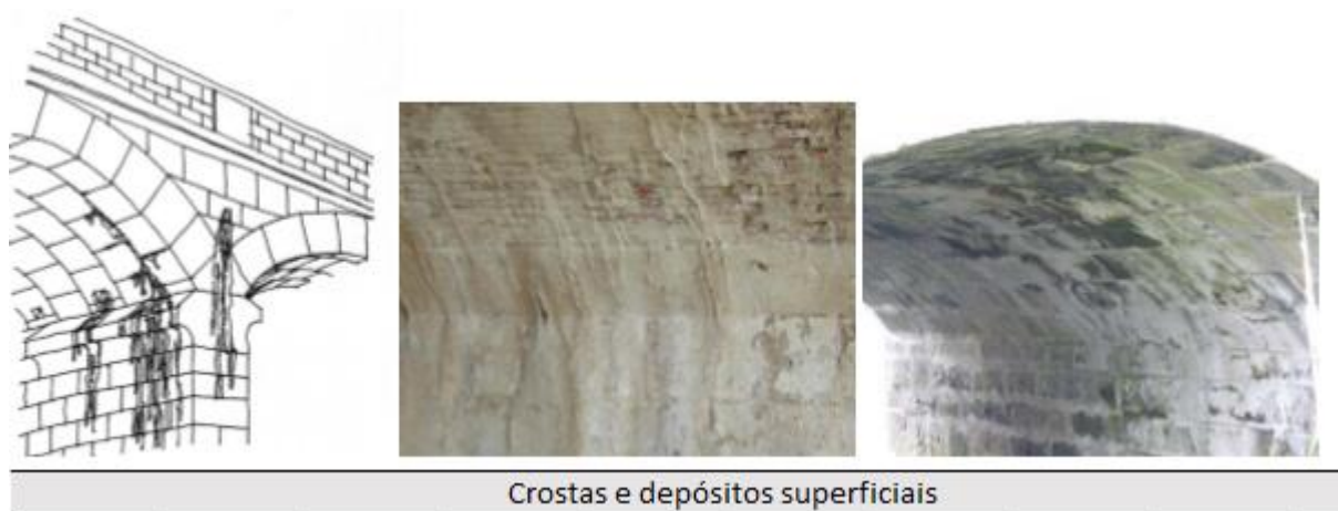
Figura 21 Crostas e depósitos superficiais (García-Catalán & Álamo, 2006)
