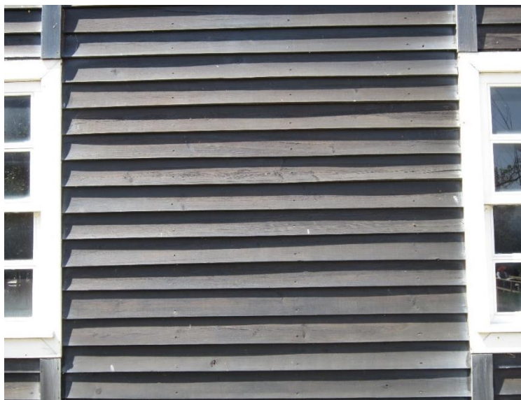
Figura 55 - Revestimento da fachada do Museu de Praia de Mira
