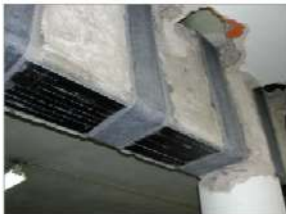
Figura 28 - Técnica EBR com laminados[38].
