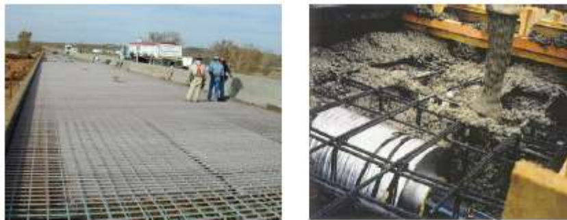
Figura 26 - Aplicação de FRP no tabuleiro de uma ponte[36].
