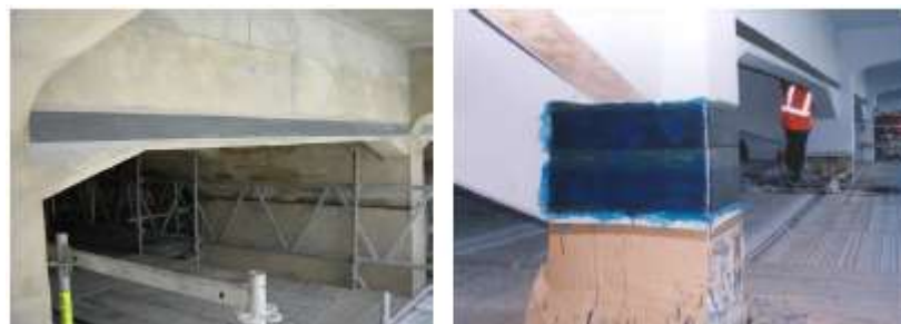
Figura 27 - Aplicação de FRP para reforço/reabilitação de pontes[36].
