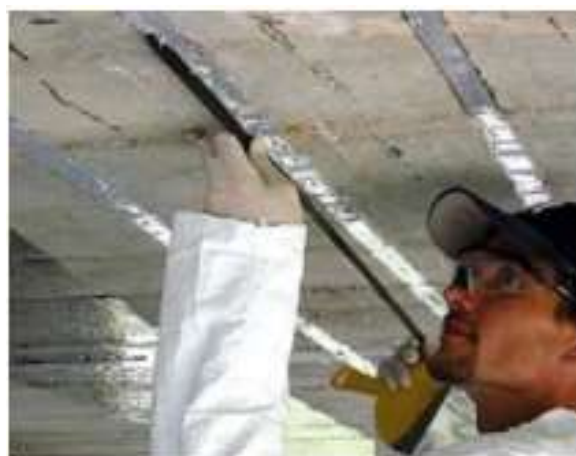
Figura 29 - Técnica NSR com laminados[38].
