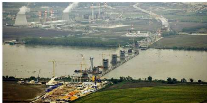
Figura 4 - Construção da Ponte da Lezíria[9]
