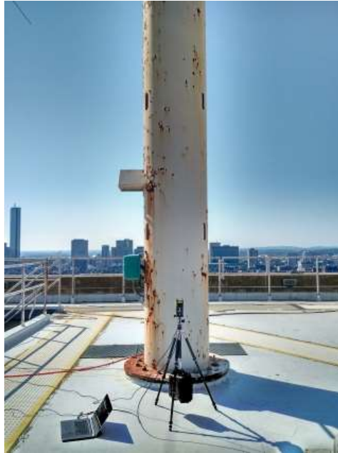
Figura 8 - Sistema de monitorização de vibrações através de laser[12].
