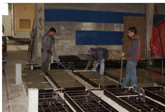
Fig. 3.4 – Betonagem.
