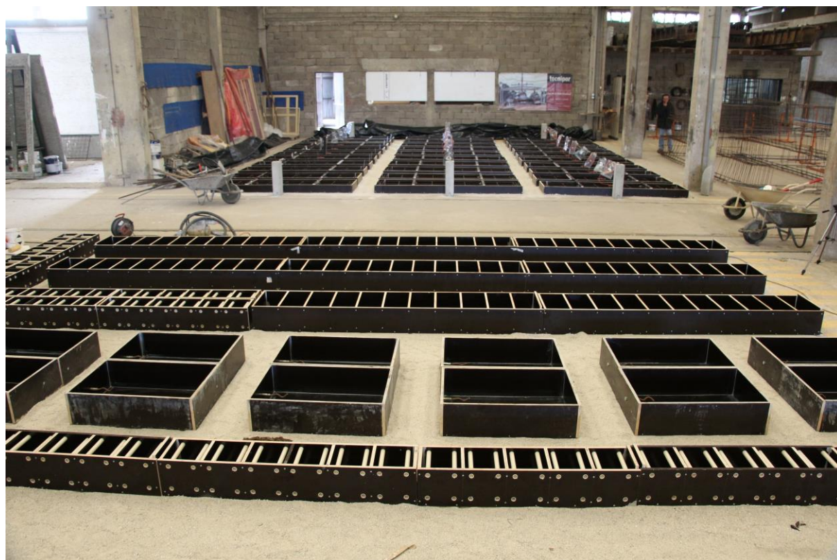
Fig. 3.1 – Perspetiva geral das cofragens utilizadas.
