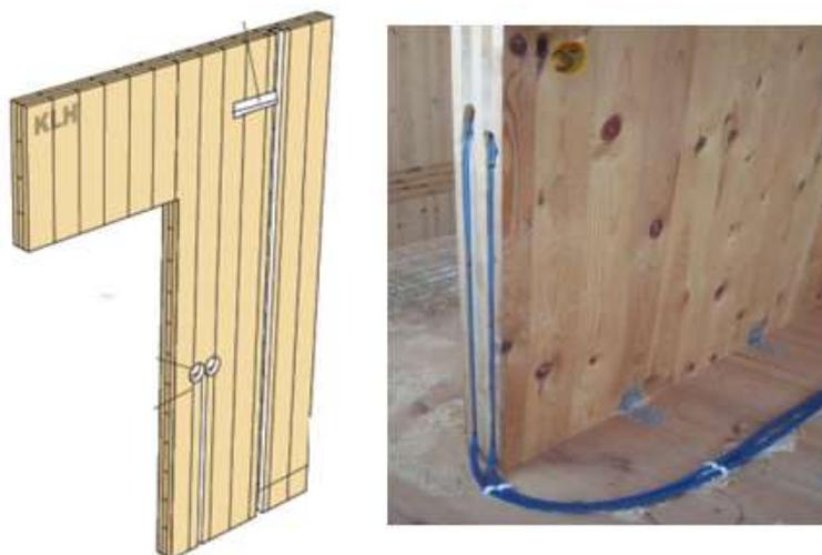
Figura 18 – Furações e roços em painéis CLT para à aplicação de redes (Jorge, 2013).
