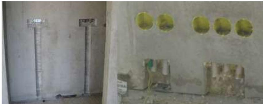
Figura 23 – Roços e dutos em paredes de cofragem integrada (Alpha Beton, 2016).
