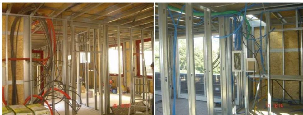
Figura 48 – Distribuição de tubagens em paredes de com estrutura em aço leve – distribuição convencional (Pires, 2013).
