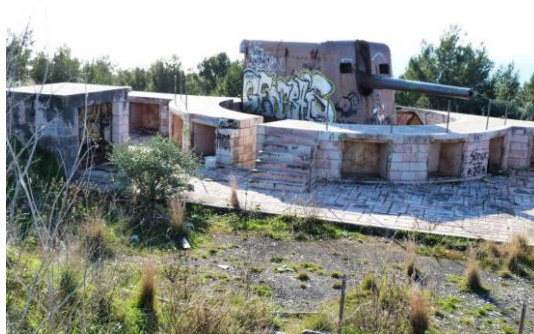
Figura 3: uma das peças de artilharia vandalizada e espaço circundante
