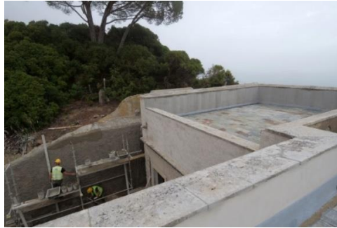
Figura 38: obras no exterior do forte de Albarquel
