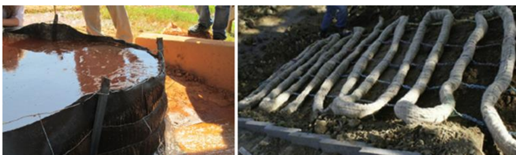
Figura 10. (Izquierda) Barrera geotextil denominada silt-fence [66]; (Derecha) Colocación del geotextil de Kemafil en la superficie de la pendiente [67]
