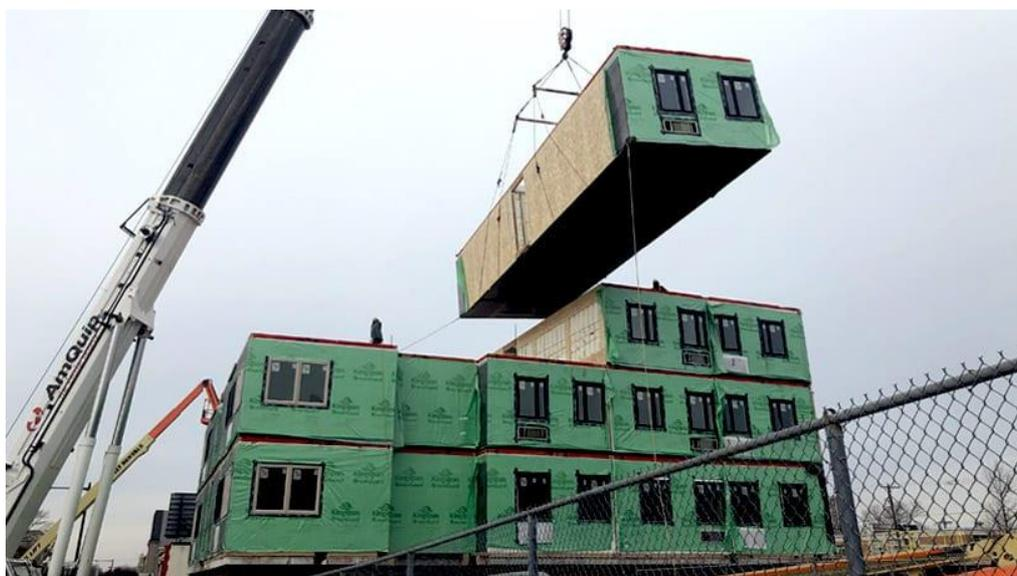
Figura 69: Exemplo de edifício executado com módulos
