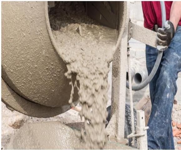
Figura 18: Amassadura por meio de betoneira
