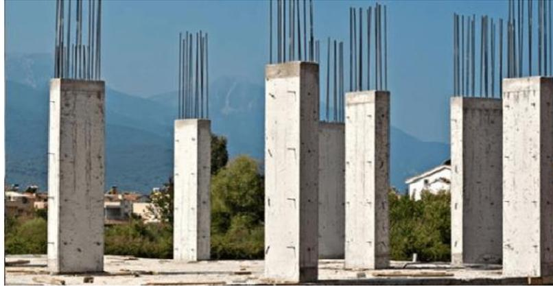
Figura 25: Pilares em betão armado
