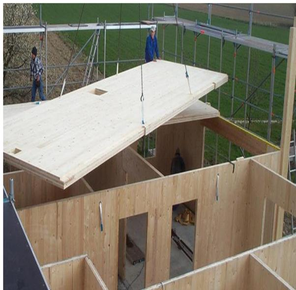
Figura 76: Aplicação de painéis CLT em coberturas
