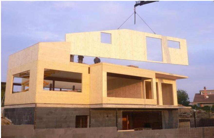
Figura 74: Exemplo de aplicação de painéis pré-fabricados
