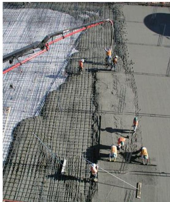
Figura 39: Processo de betonagem e pormenor de armadura de uma laje
