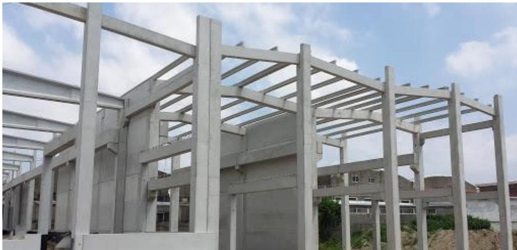
Figura 61: Estrutura em betão pré-fabricado
