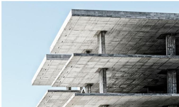
Figura 26: Lajes de piso e cobertura em betão armado
