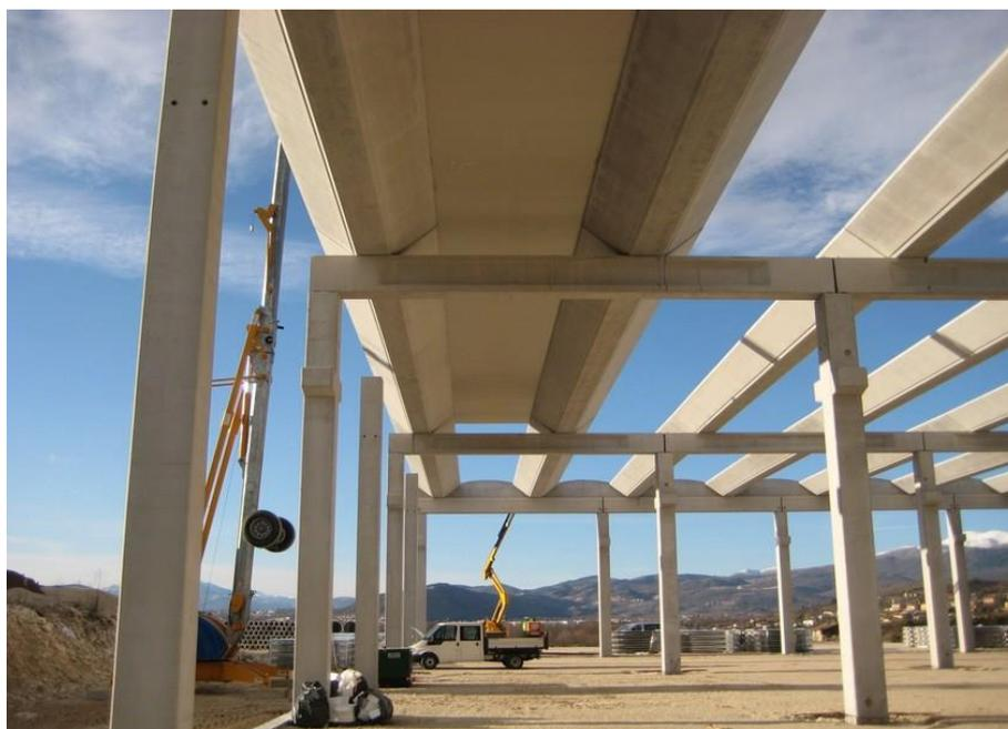
Figura 100: Estrutura executada com “frame” de betão pré-fabricado
