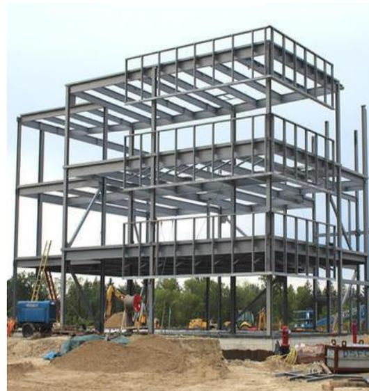
Figura 66: Exemplo de estruturas em frame
