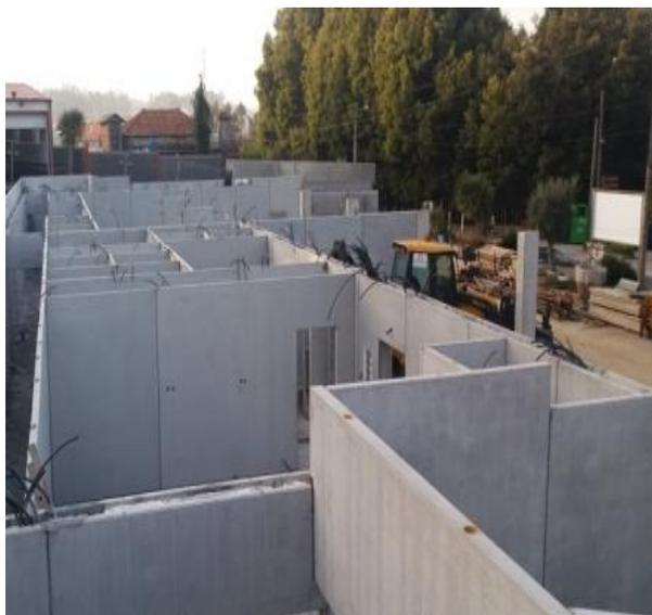
Figura 86: Estrutura executada com painéis estruturais
