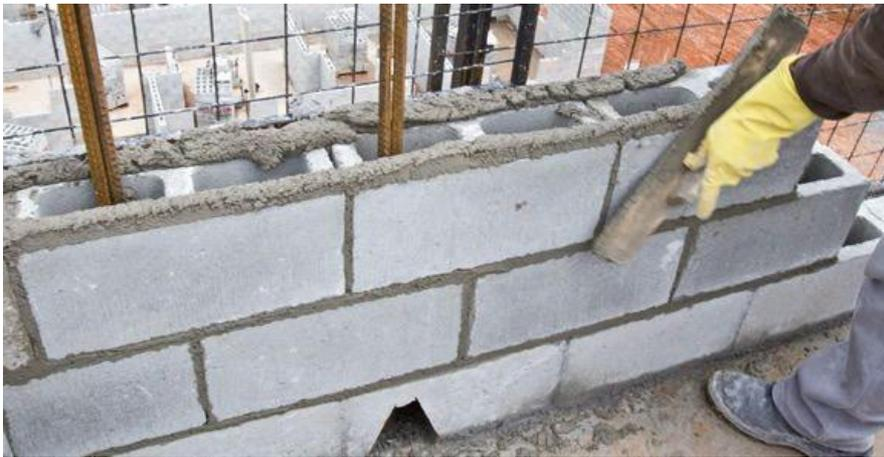
Figura 40: Assentamento de alvenaria estrutural
