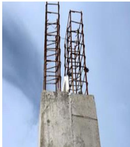
Figura 35: Pormenor da armadura dos pilares
