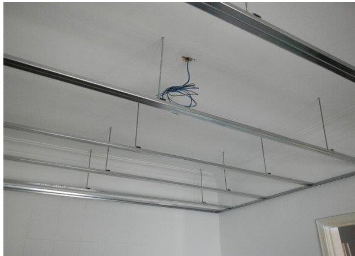
Figura 134: Estrutura de suporte para teto falso
