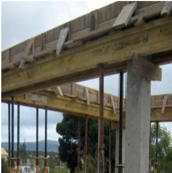
Figura 36: Cofragem de viga
