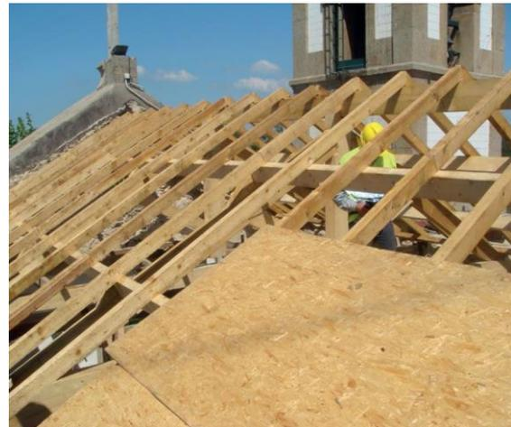
Figura 78: Exemplo de aplicação das placas OSB
