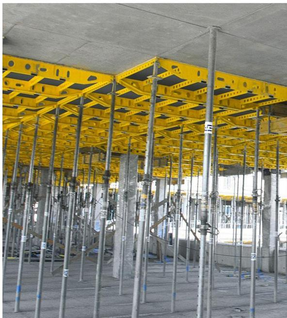
Figura 38: Cofragem de uma laje
