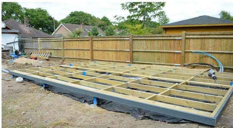
Figura 96: Fundações de uma estrutura executada com “*frame*” de madeira
