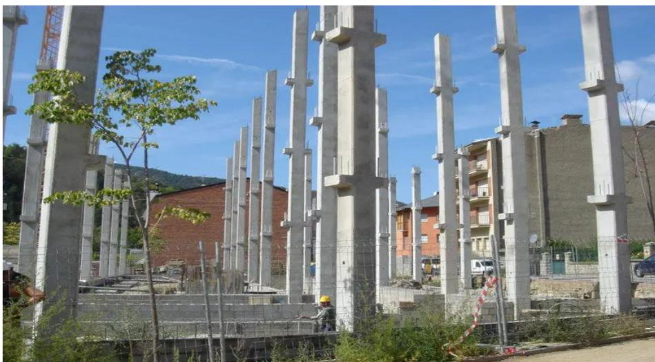
Figura 99: Pilares pré-fabricados
