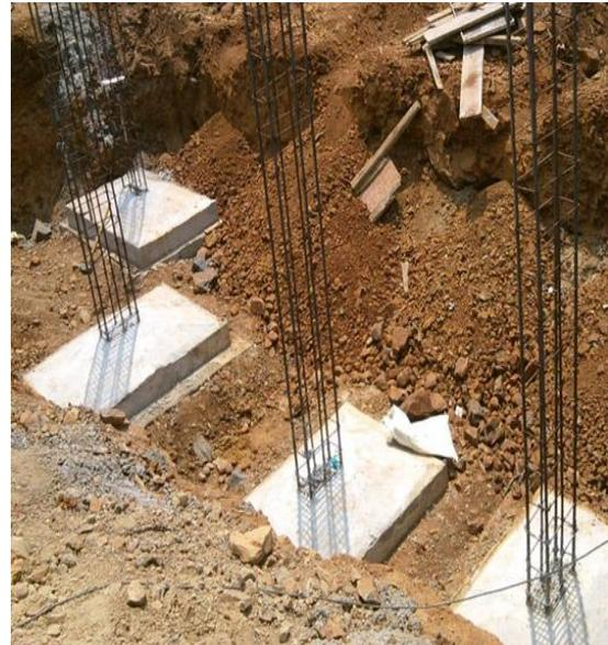
Figura 33: Execução das sapatas de fundação
