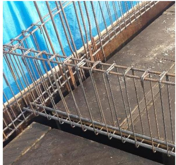
Figura 37: Pormenor de armadura de viga
