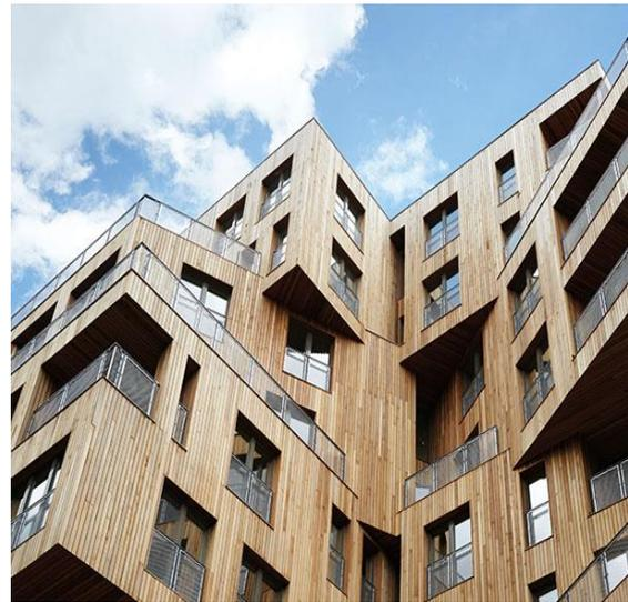
Figura 52: Estrutura concebida em CLT
