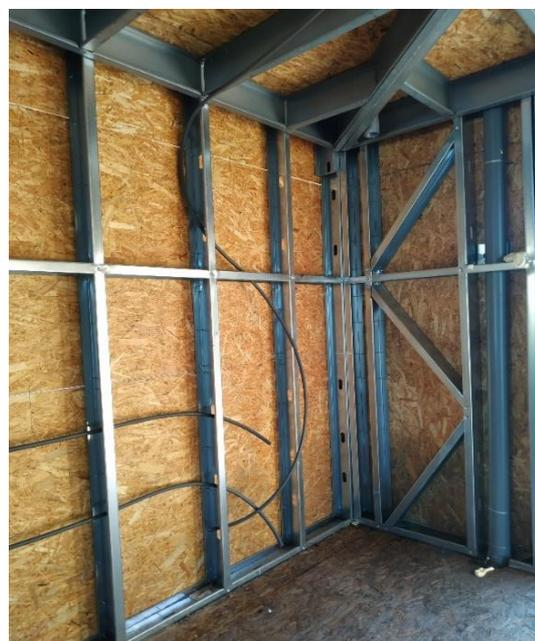
Figura 95: Revestimento da estrutura LSF com placas OSB
