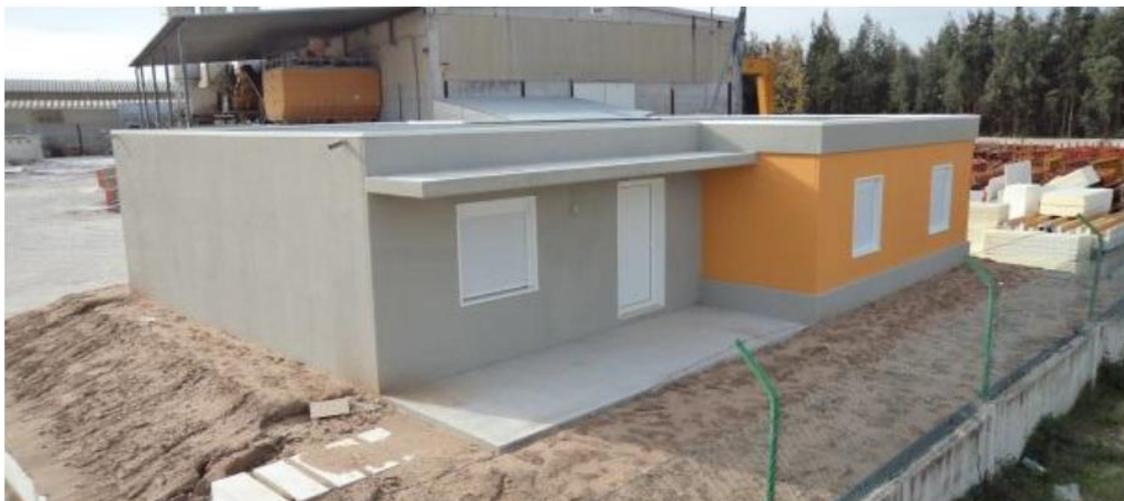
*Figura 83: Protótipo construído com painéis sandwich com camadas em BACRFA e conectores em GFRP (Retirado de (Barros et al., 2015))*
