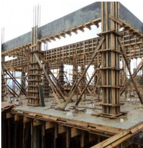
Figura 34: Execução dos pilares
