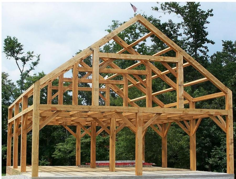
Figura 97: Estrutura executada com “frame” de madeira
