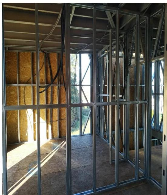
Figura 94: Estrutura executada em LSF
