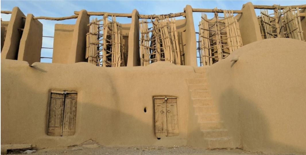
Figura 2.27 - Moinho de vento semelhante ao de *Seistan*. Adaptado de (SURFIRAN, s.d.)
