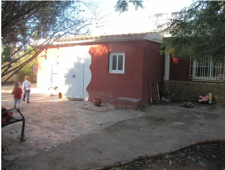
Fotografia 4. Casa de pedra- Da autora
