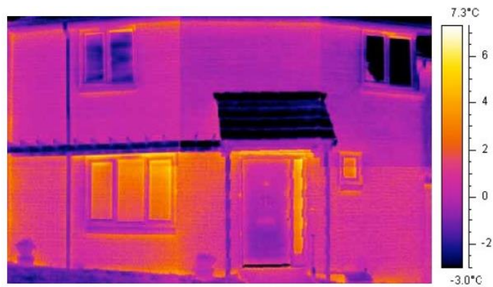
Figura 13 - Imagem termográfica da casa em alvenaria com escala de temperatura [34].
