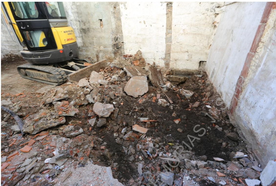
Foto 14 (IMG_5201) – Início dos trabalhos de decapagem do terreno.
