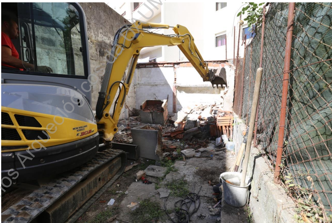
Foto 13 (IMG_5162) – Acompanhamento da demolição do anexo na área do logradouro.
