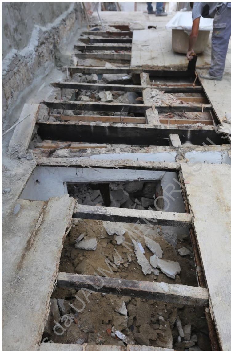
Foto 9 (IMG_5095) – Acompanhamento dos trabalhos de demolição do piso superior.
