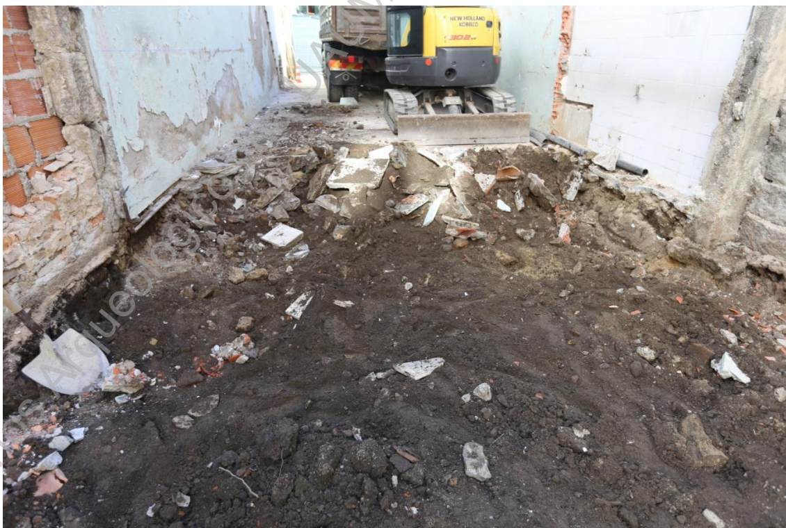
Foto 15 (IMG_5356) – Acompanhamento do trabalho de decapagem do terreno.
