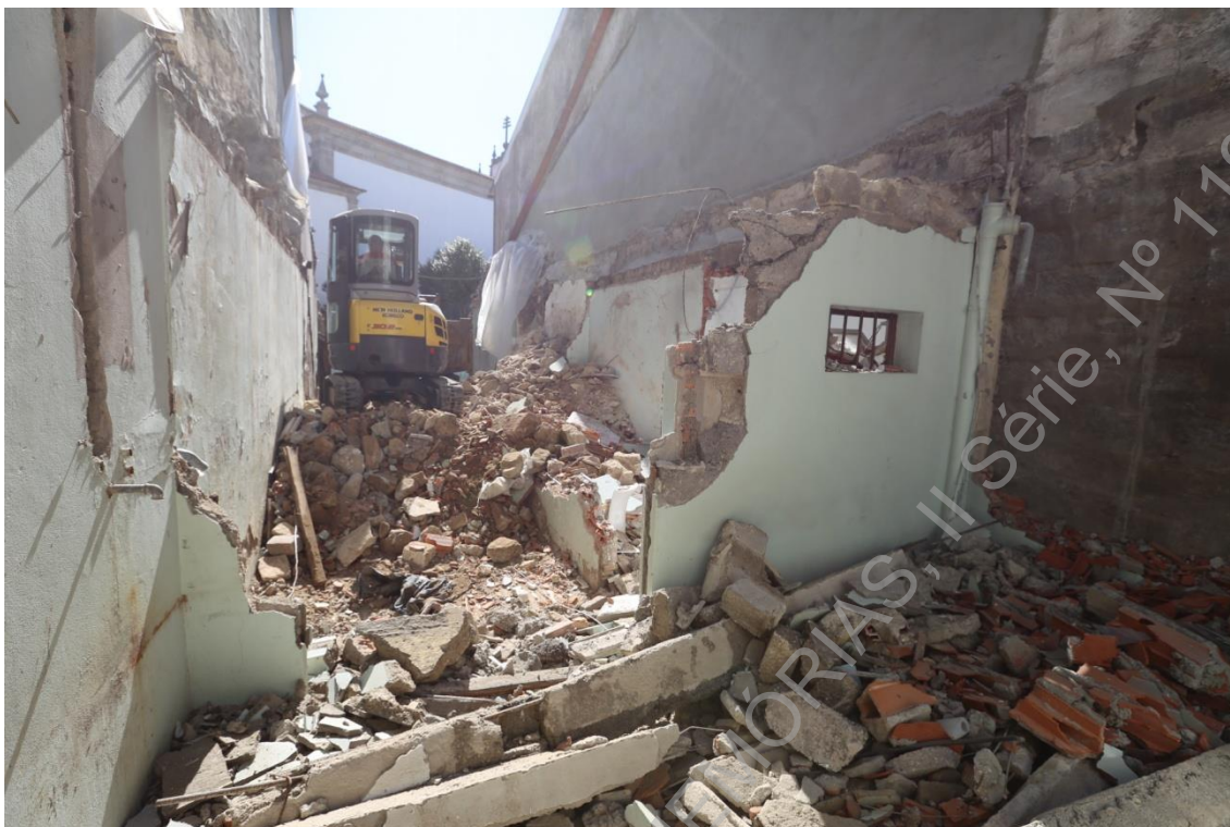
Foto 10 (IMG_5118) – Acompanhamento do trabalho de demolição da compartimentação interna do rés-do-chão.
