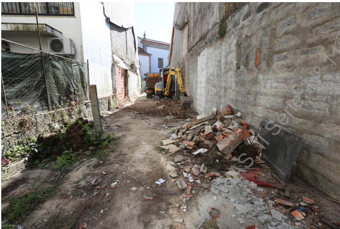
Foto 12 (IMG_5155) – Conclusão da demolição interna da antiga habitação.
