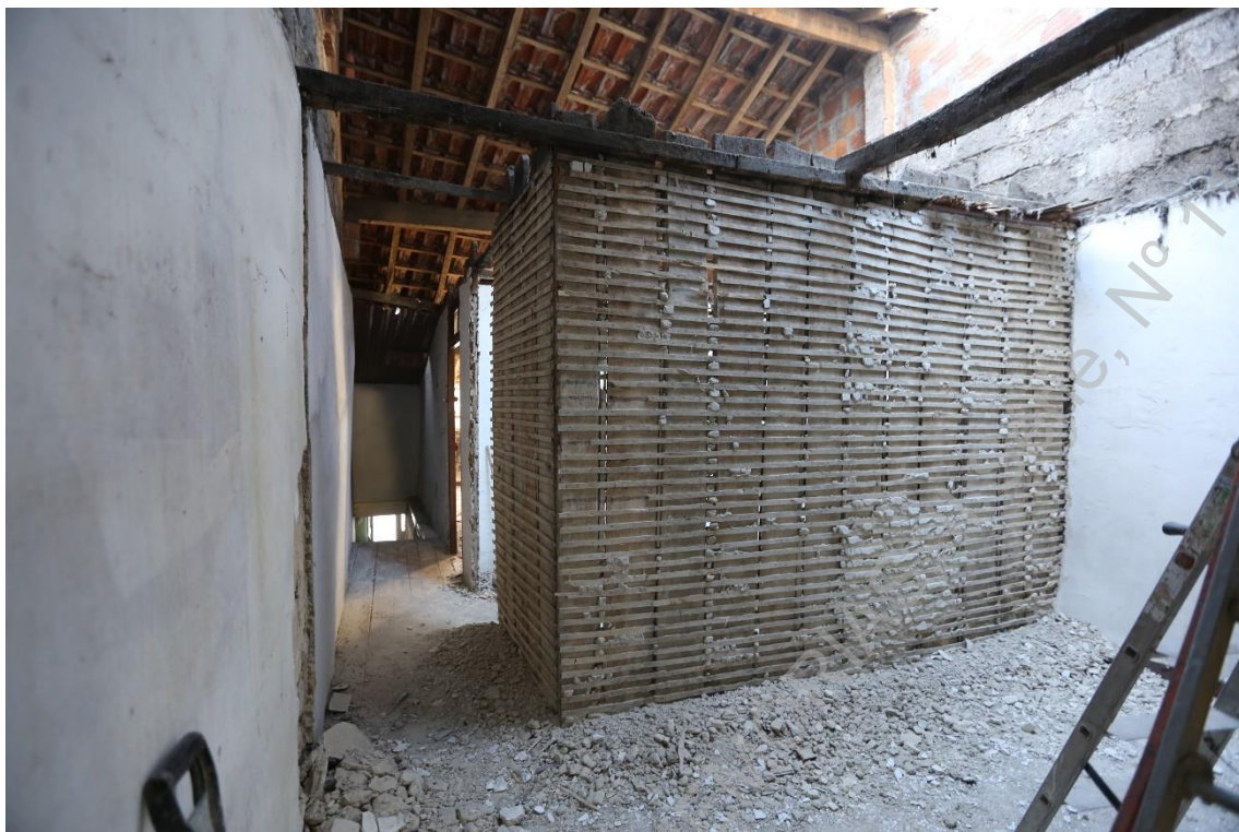
Foto 5 (IMG_5054) – Pormenor de paredes em taipa de compartimento no primeiro piso.
