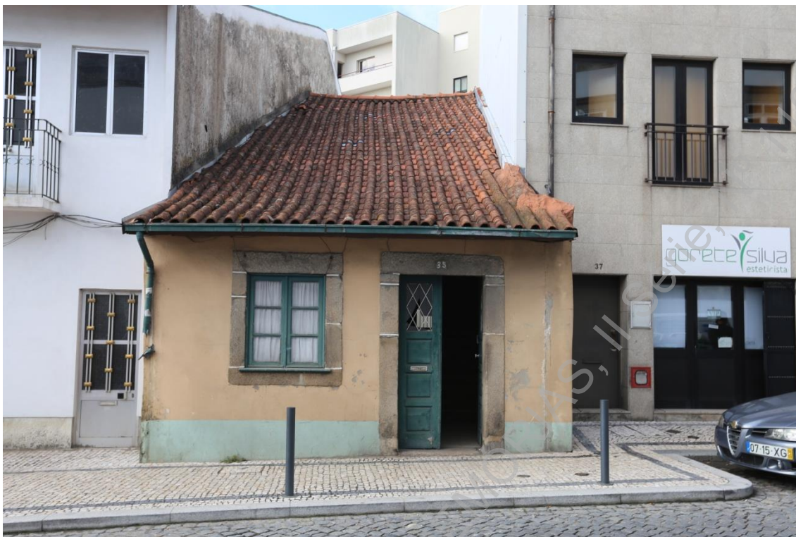
Foto 1 (IMG_5025) – Fachada do edifício localizado no nº35 da rua Conselheiro Januário.
