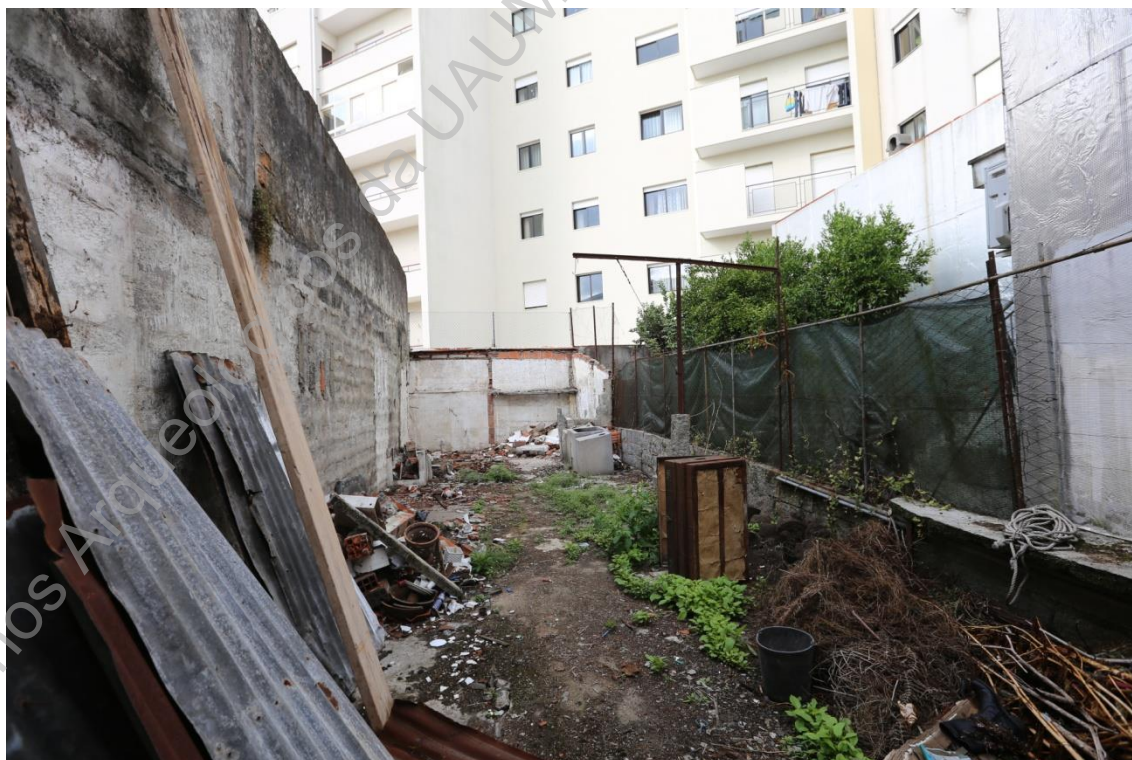
Foto 4 (IMG_4987) – Perspetiva geral da área de logradouro da antiga habitação.
