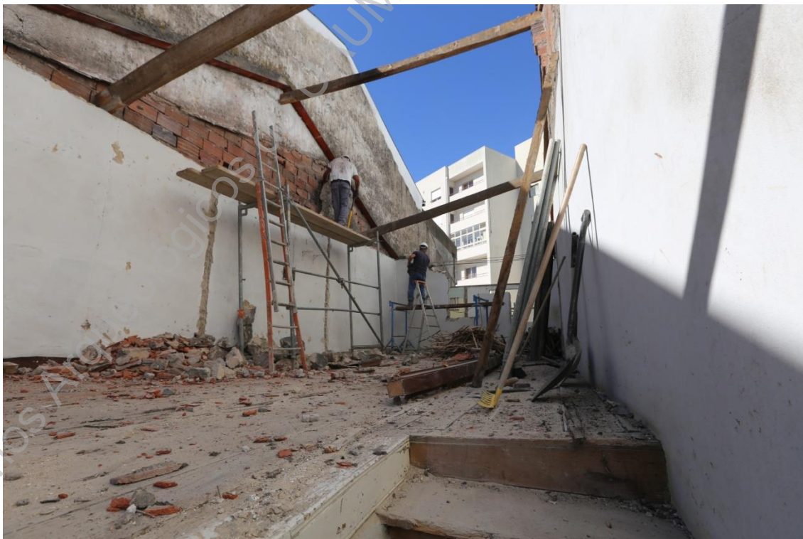
Foto 6 (IMG_5071) – Acompanhamento da remoção de telhado.
