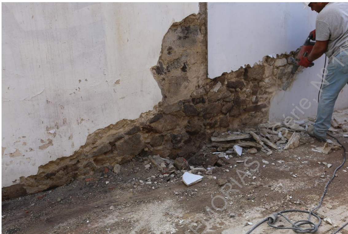
Foto 7 (IMG_5090) – Acompanhamento de remoção do estuque de paredes no piso superior.
