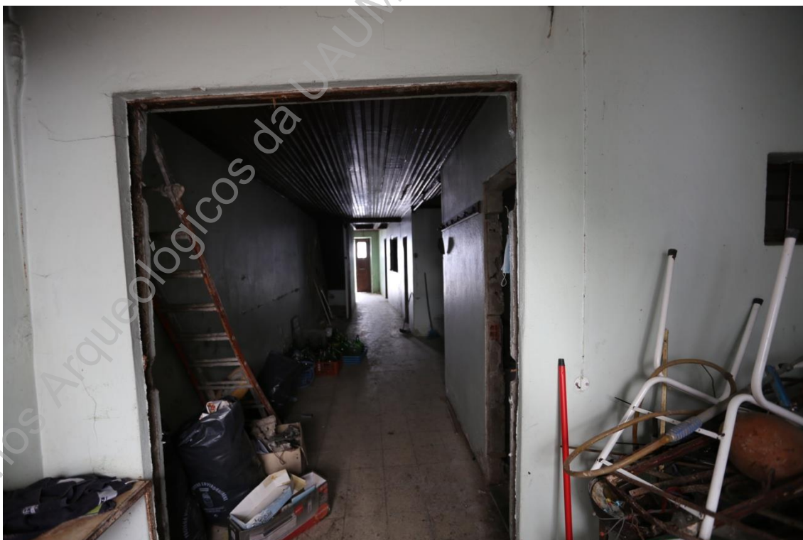
Foto 2 (IMG_4994) – Perspetiva geral do piso térreo da antiga habitação.
