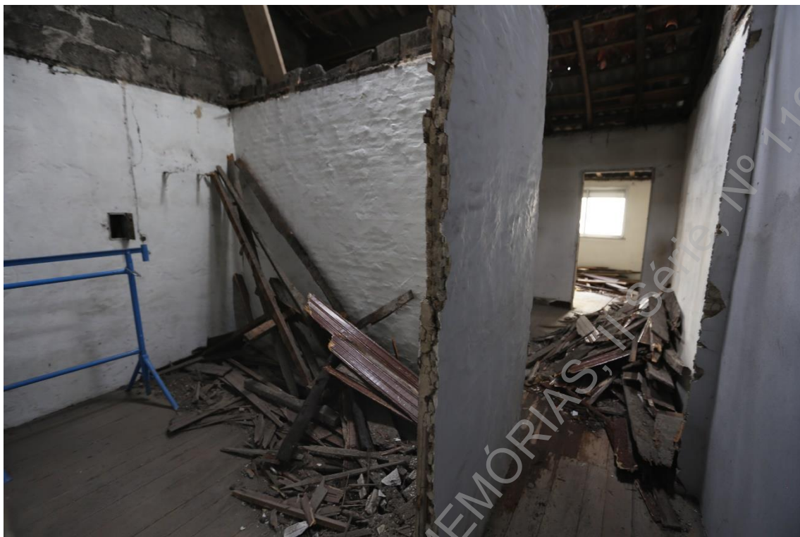
Foto 3 (IMG_5014) – Perspetiva geral do primeiro piso da antiga habitação.
