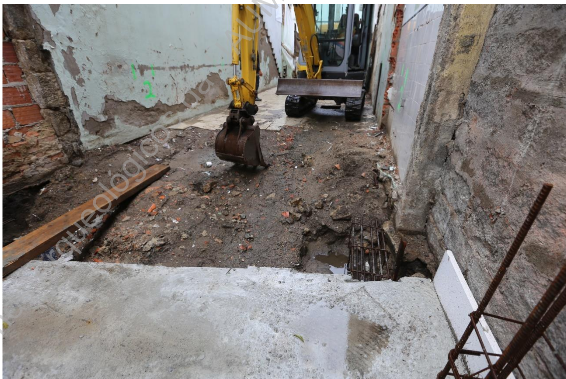
Foto 19 (IMG_9137) – Pormenor da continuação da decapagem mecânica do terreno.
