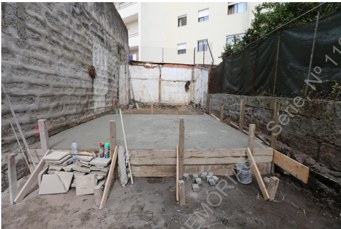
Foto 16 (IMG_8852) – Betonagem da sapata para suporte da grua.
