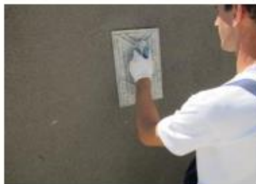
Figura 17 e 18: Aplicação da Ecocork Lime com a utilização de régua para regularização e talochamento da superfície final. Fonte: estmatsol.pt (2021).
