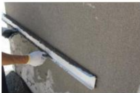
Figura 17 e 18: Aplicação da Ecocork Lime com a utilização de régua para regularização e talochamento da superfície final. Fonte: estmatsol.pt (2021).
