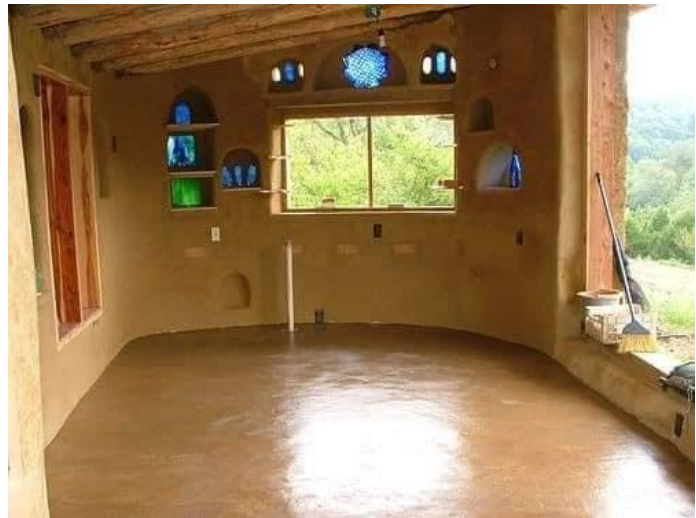
Figura 10 e 11: Aplicação de Cob na parede interior de uma residência e resultado final da utilização de Cob nas paredes e piso. Fonte: Earthship Experience (2021).
