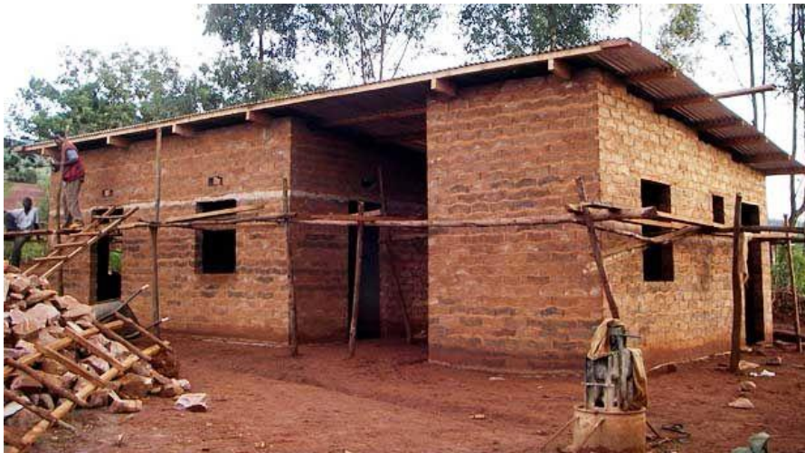
Figura 7: Residência construída com a utilização de BTC. Fonte: Project Riad (2018).
