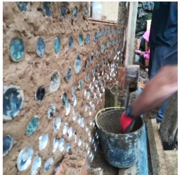
Figura 5 e 6: Construção de paredes utilizando latas de alumínio e garrafas de vidro pela Earthship Experience. Fonte: @earthshipexperience (2021).
