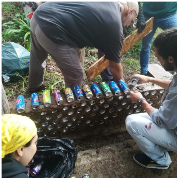
Figura 5 e 6: Construção de paredes utilizando latas de alumínio e garrafas de vidro pela Earthship Experience. Fonte: @earthshipexperience (2021).
