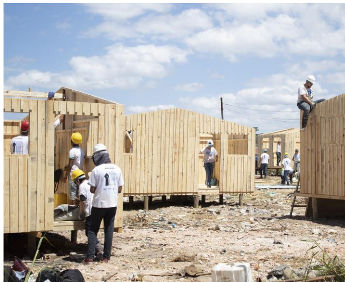
Figura 8: Moradias sendo construídas por voluntários da ONG TETO. Fonte: Globo (2019).
