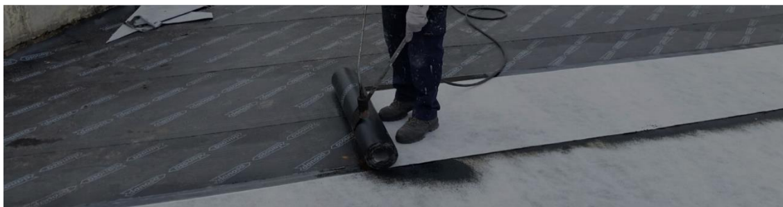
Figura 35 - Aplicação de tela asfáltica (reproduzido de (CAPIO, n.d.))
