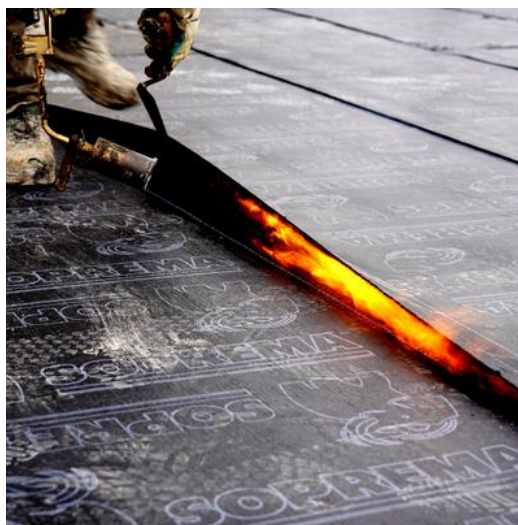
Figura 39 - Impermeabilização à base de membrana de betume plastómero (reproduzido de (SOPREMA, n.d.))
