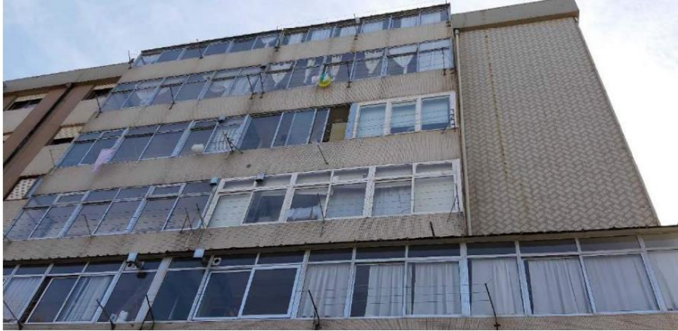
Figura 72 - Pormenor dos andares de habitação da fachada Sul
