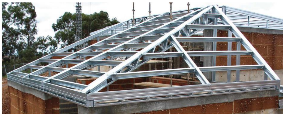
Figura 22 - Estrutura de suporte de cobertura inclinada com perfis metálicos (reproduzido de (SERVISTEEL - Soluções Técnicas e Engenharia, Lda., 2017))
