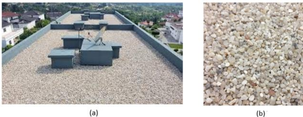
Figura 45 - a) Camada de proteção efetuada com areão; (b) Pormenor do material (reproduzido de (Prudêncio, n.d.))
