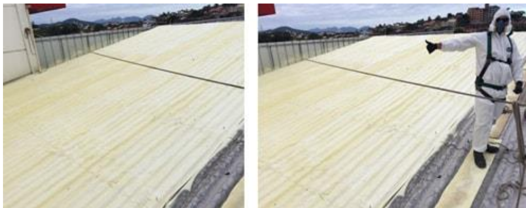
Figura 38 – Aplicação de membrana líquida de poliuretano (reproduzido de (purcom, n.d.))
