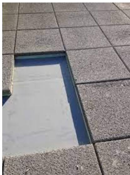
Figura 46 - Camada de proteção à base de lajetas térmicas (reproduzido de (ISOCENTRO, n.d.))
