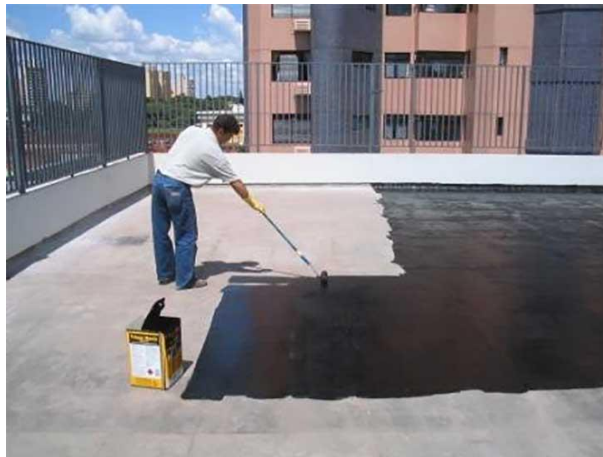
Figura 37 – Impermeabilização à base de tela líquida de borracha (reproduzido de (2M Resinas, n.d.))
