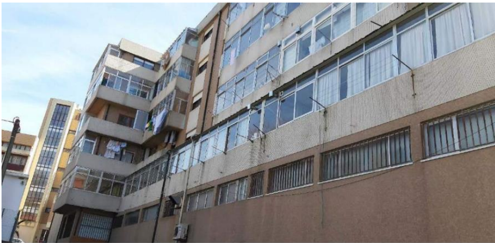
Figura 73 - Pormenor dos andares de habitação da fachada Norte
