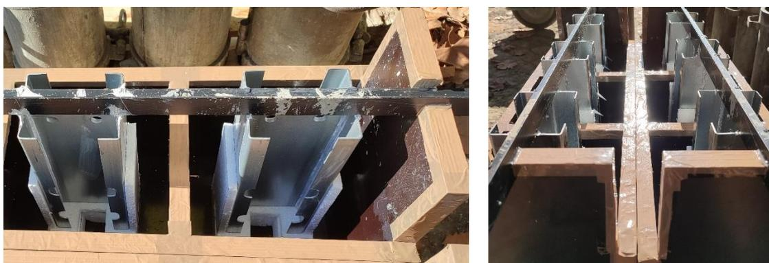
Figura 4.12 Sistema auxiliar de suporte aos perfis metálicos implementado na cofragem.
