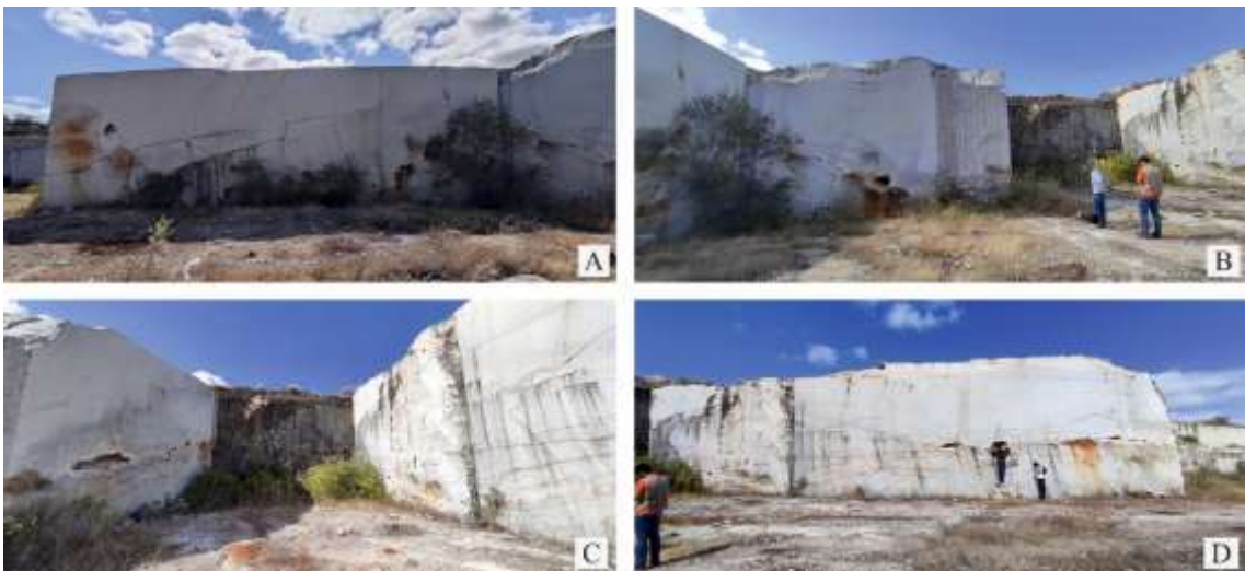
Figura 2.6 – Levantamento fotográfico de uma das frentes de desmonte da pedreira de Malpartida onde é possível observar um veio pegmatítico apresentando cavidades miarolíticas (julho, 2021).
