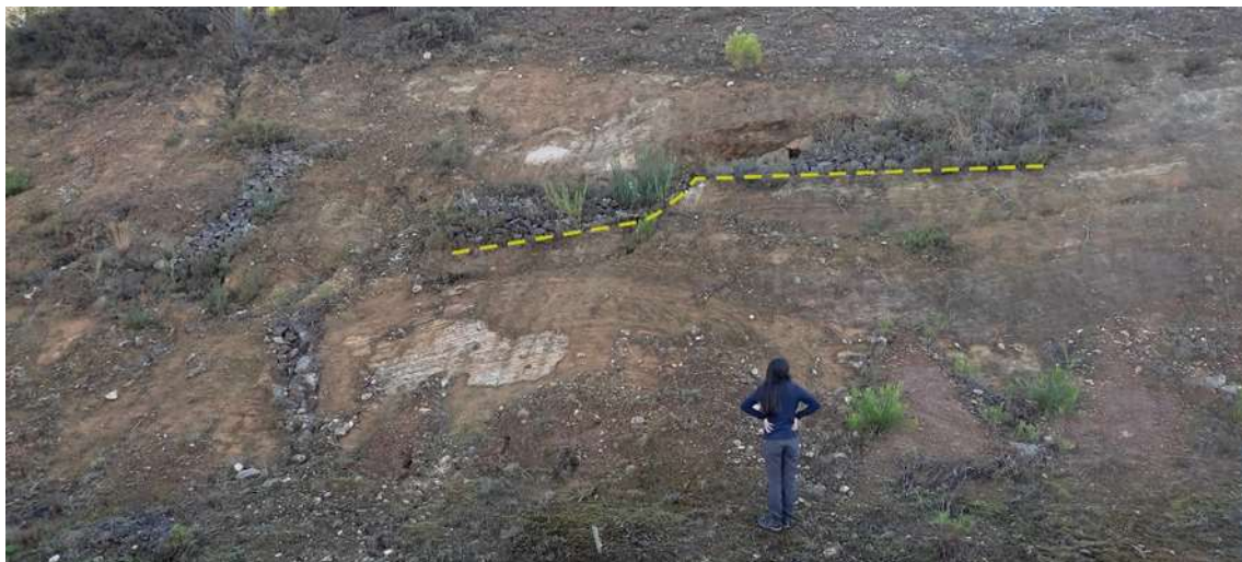
Figura 2.3 – Fotografia do talude onde se observa o fenómeno estrutural kink-bands mencionado por Lobarinhas, Dias & Leal Gomes (2014) e os pegmatitos preenchidos por pedras à esquerda da foto (novembro, 2021).
