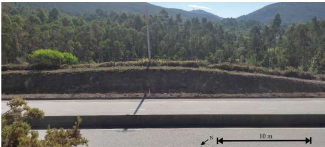
Figura 4.5 – Levantamento fotográfico do talude oposto da passagem do GPR (outubro, 2021).
