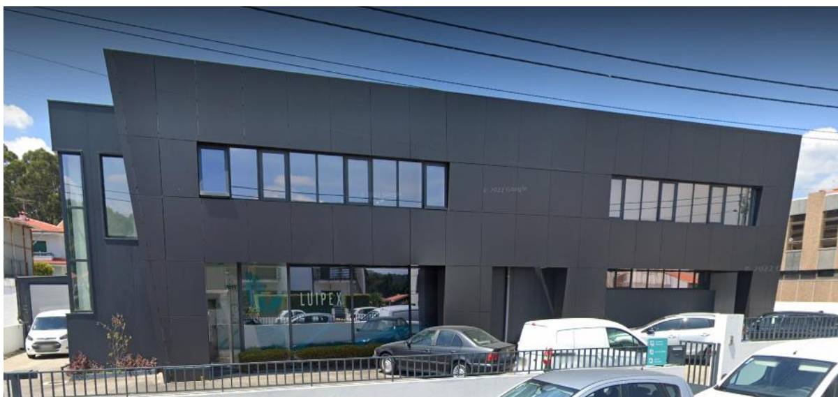
Figura 2- Fachada da Empresa
