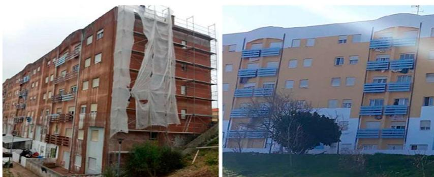
**Figura 52: Bairro Pendão em Sintra antes e depois da reabilitação pelo sistema ETICS**
