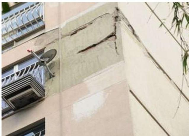
**Figura 51: Estrutura de betão com perda de capacidade de carga [132]**
