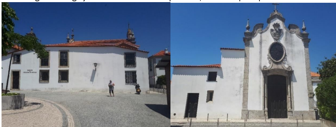
Figura 16 - Igreja da Misericórdia de Esposende, fachadas principal e lateral
