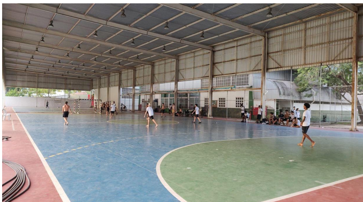
Figura 4 - Quadra em que foram realizadas as observações das aulas de Educação Física. Ao fundo se encontra o Ginásio Desportivo
