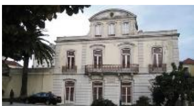
Figura 6 - Edifício na Travessa Conde de Soure, 22. Local possível do antigo Teatro do Bairro Alto
